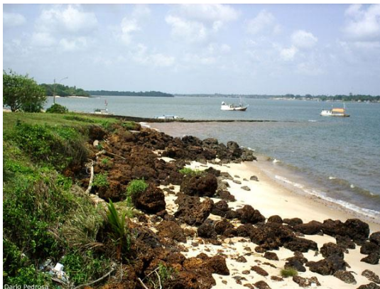
Figura 5 – Pedras de Proteção Natural do Barranco próximo ao Porto.
