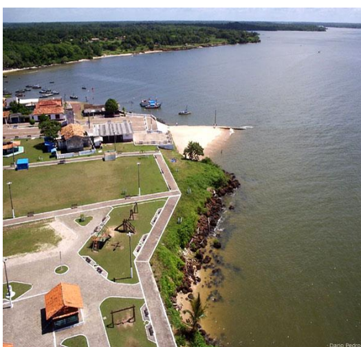
Figura 10 – Frente de Salvaterra Vista do alto. Pedras de Proteção
