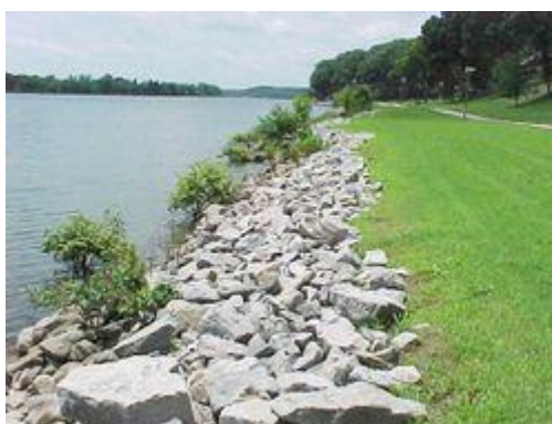
Figura 13. Enrocamento ficando a margem.
