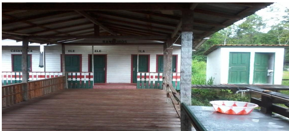
Imagem2. Banheiros da EMEF Bom Jesus
