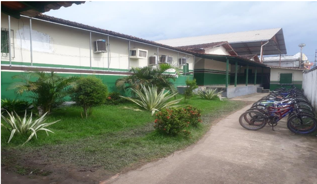
Imagem 02: Bicletário/área de blocos de salas de aula.
