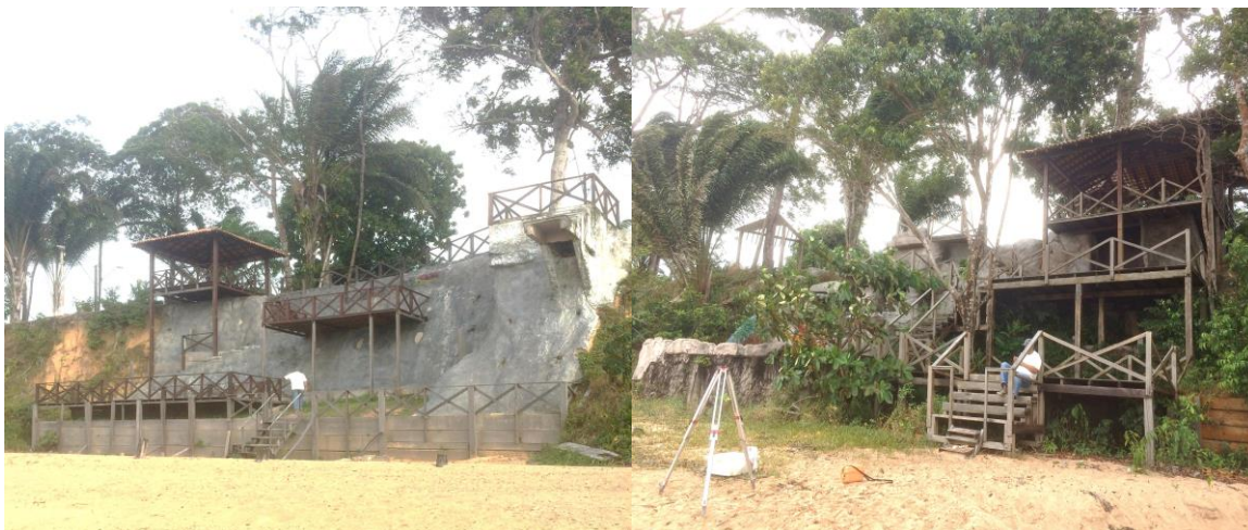
Figura 3- Ocupação sobre falésias no setor oeste com revestimento por concreto e construções de casas.
