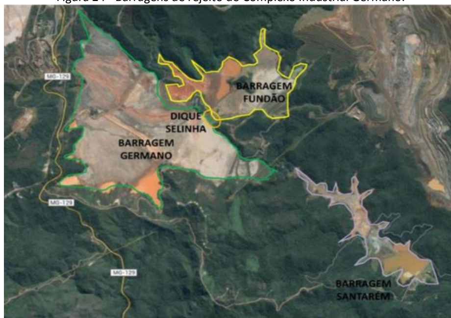
Figura 24 - Barragens de rejeito do Complexo Industrial Germano.
