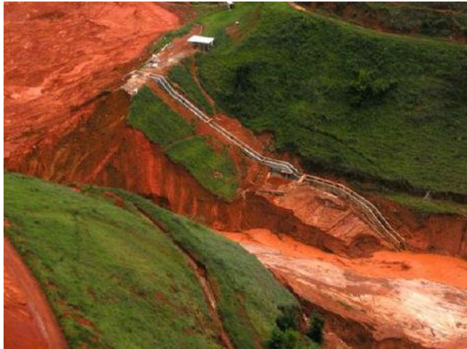
Figura 16- Vista da barragem de rejeitos após ruptura.
