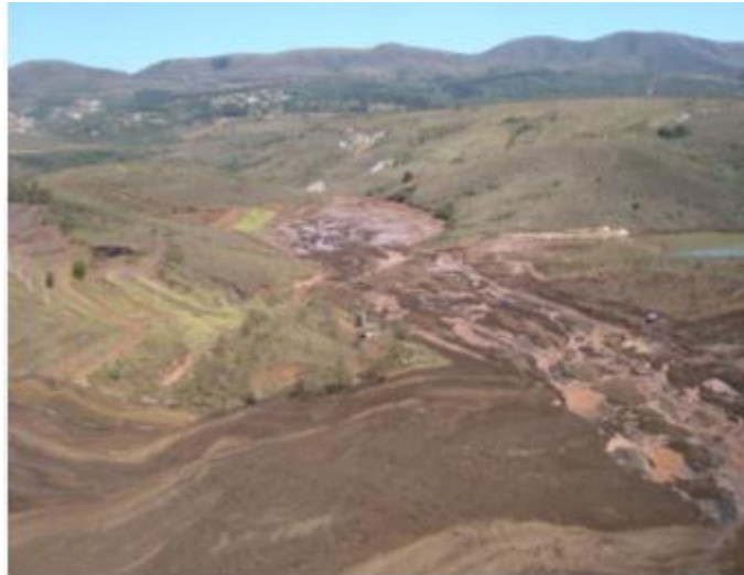
Figura 22 - Vista do material do rompimento da B1 retido no vale a montante da B3.
