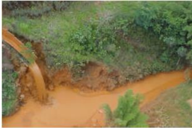
Figura 15 – Vertedor lançamento lama diretamente no Córrego Bom Jardim.
