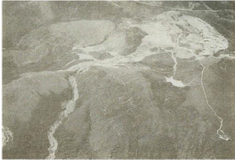
Figura 13 - Vista aérea da barragem e do talvegue a jusante após a ruptura.
