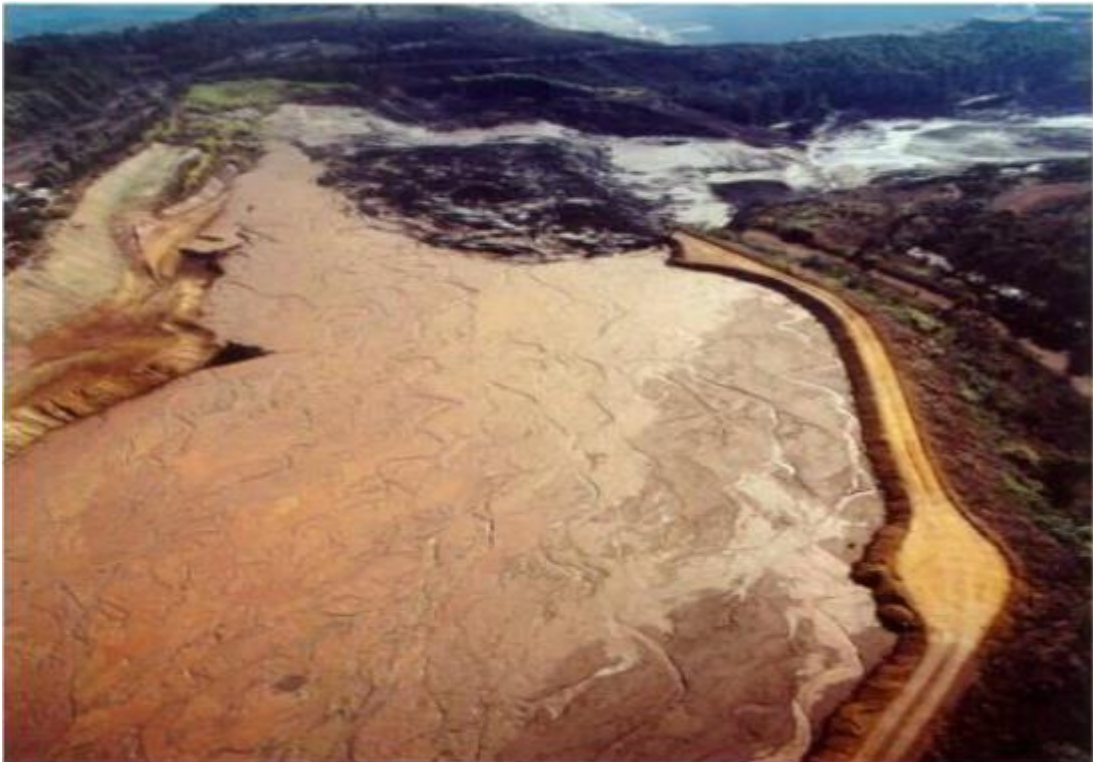
Figura 14 - Vista da barragem de rejeitos da mineração Rio Verde após a ruptura.
