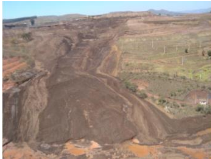
Figura 19 - Vista de frente do movimento de massa proveniente do colapso da B1.
