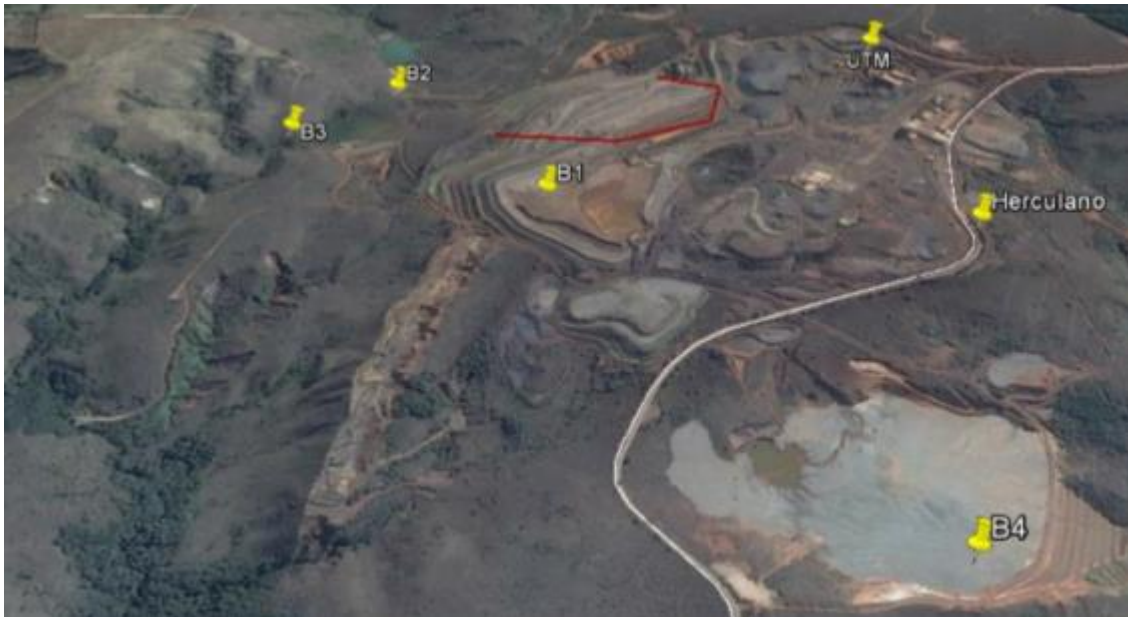
Figura 17 - Demonstração das estruturas (barragens B1, B2, B3, B4 e beneficiamento) do empreendimento, vale do afluente do córrego do Silva e local do rompimento da barragem B1 (linha em vermelho).
