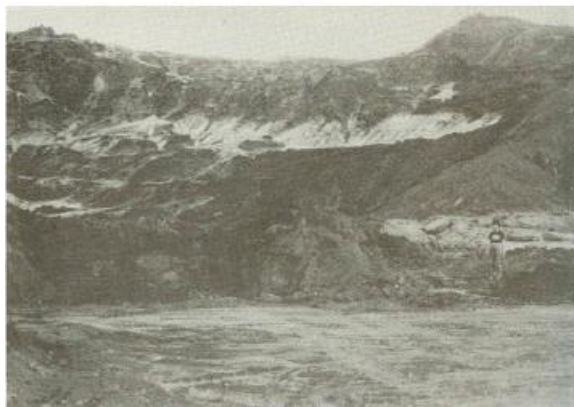
Figura 12 - Cicatriz deixada pela ruptura da Barragem de Fernandinho.
