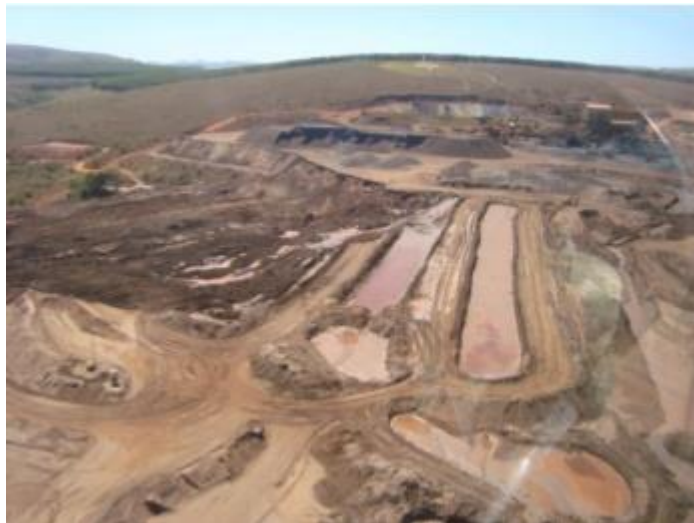
Figura 18 - Vista do local de ruptura e baias restantes utilizadas no lago de deposição da B1.
