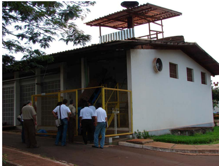
Figura 5.1-1. Instalações do Incinerador no Hospital de PTR Fonte: MRN
