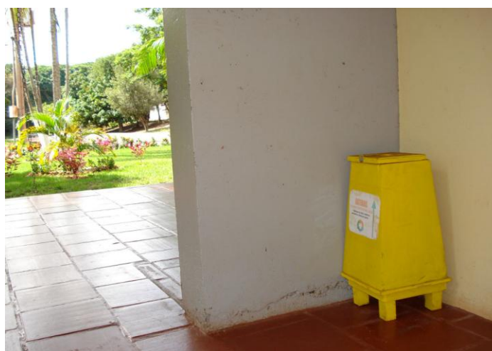
Figura 5.3-15. Local inadequado para lixeira de recolhimento de baterias. Fonte: MRN
