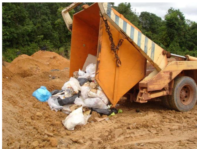
Figura 5.5.2-2. Descarte de resíduos para aterramento. Fonte: MRN
