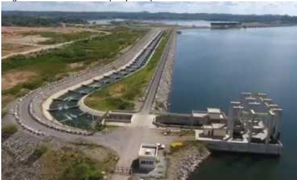
Figura 3-5 - Sistema de transposição de peixes da usina hidrelétrica de Belo Monte
