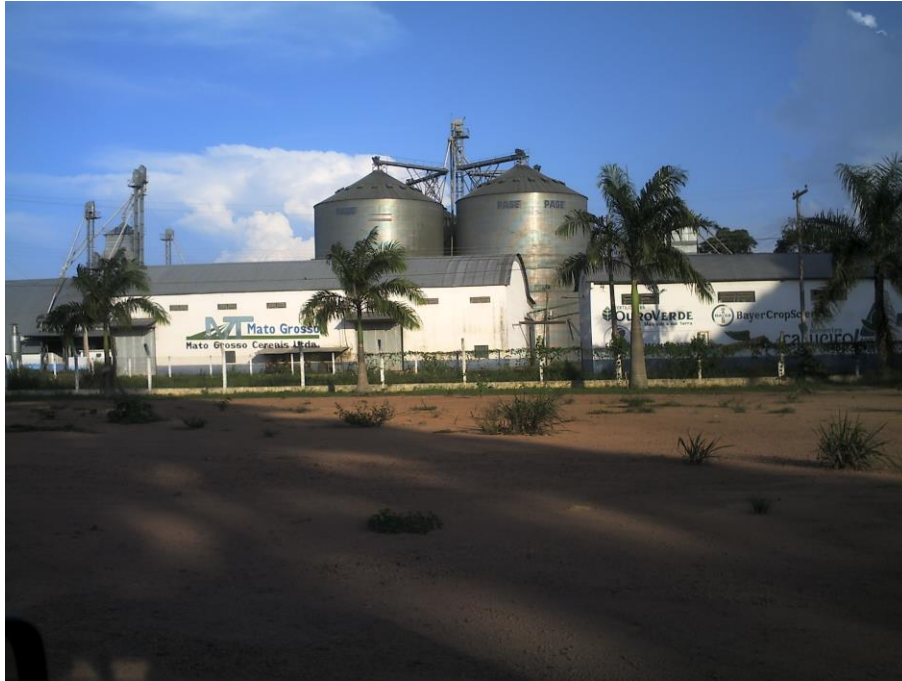
Figura 08 – Silos e Secadores.
