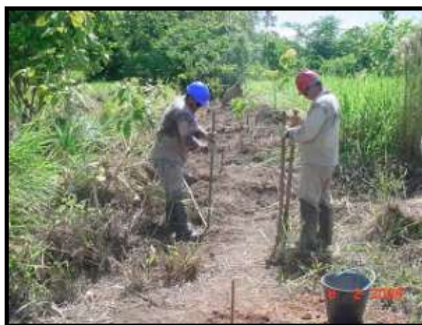
Figura 6 – Abertura de covas no setor 1-Mina do Sossego
