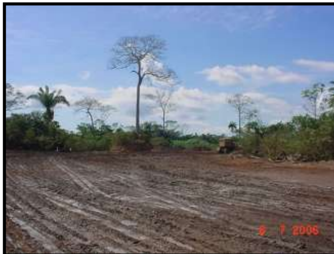
Figura 11 – Distribuição do topsoil na área 2 através de um trator D6-Mina do Sossego
