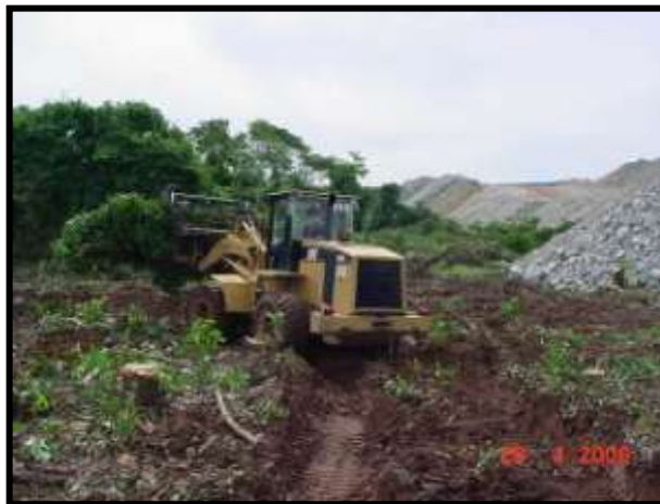
Figura 10 – Serviço de limpeza na área da UHC após a supressão vegetal-Mina do Sossego
