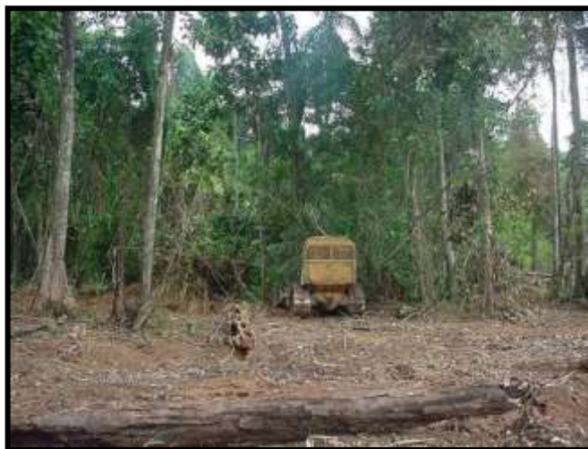
Figura 9 – Supressão vegetal com um trator D6 na área da UHC-Mina do Sossego
