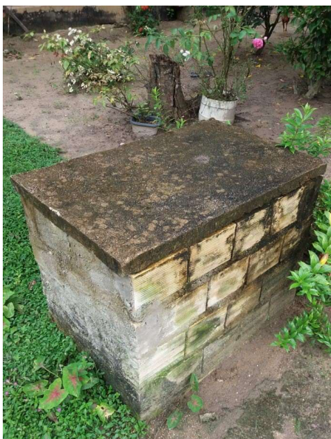
Figura 7 - Poço artesiano construído no Sítio Particular para captação da água subterrânea.
