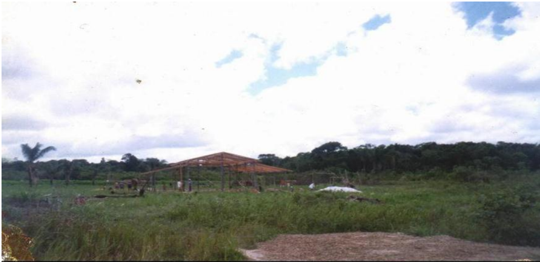
Figura 2: Construção do primeiro salão
