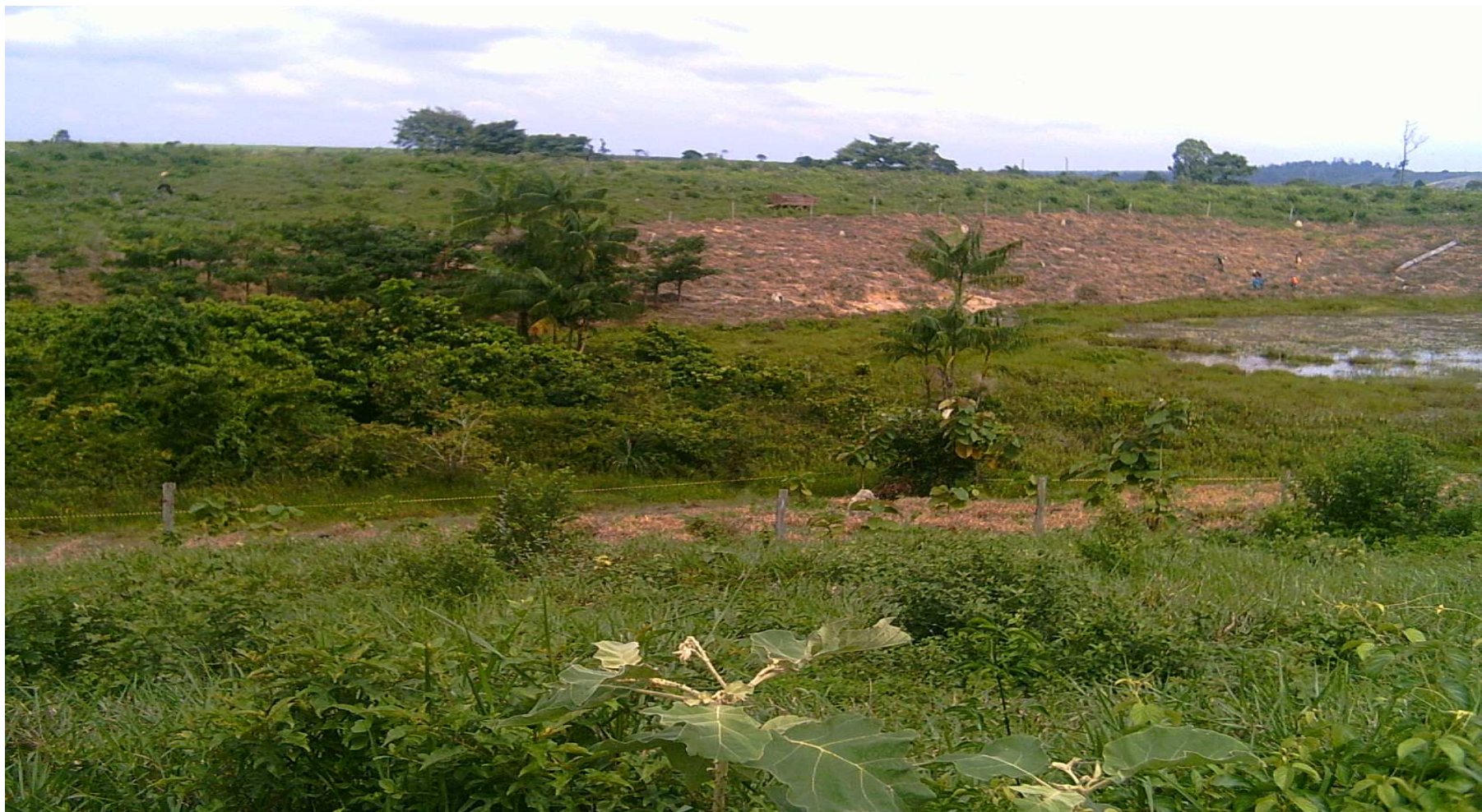
Figura 14 – Limpeza da área tomada por ecossistema de pastagem, nas margens esquerda e direita da nascente, com declividade de 15%.
