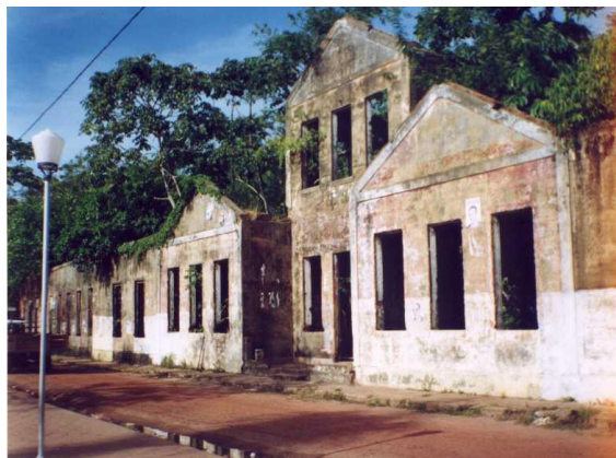
Fotografia 1: Ruínas do Educandário Nogueira de Farias. Fonte: Gonçalves (2010).
