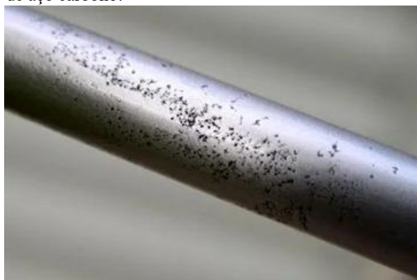
Figura 5 - Corrosão por pite de aço carbono.
