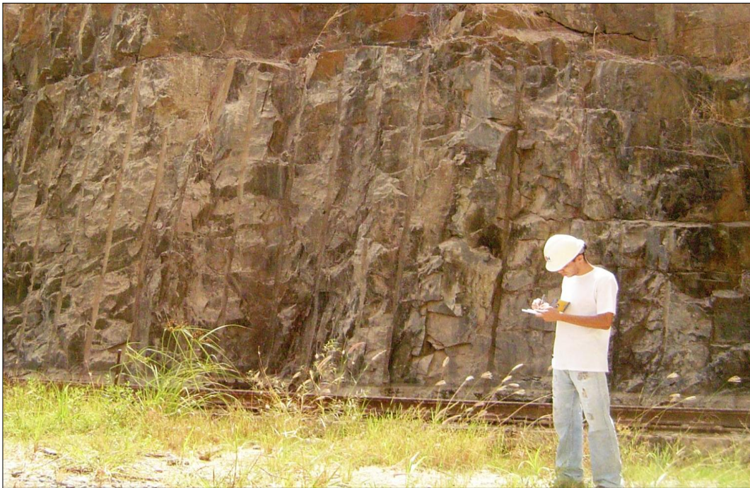
Figura 7.2 – Corte artificial em uma parede dinamitada com exposição de uma camada de derrame basáltico. Localizado na Eclusa 01 da UHT (Ponto 2006/TU-02).
