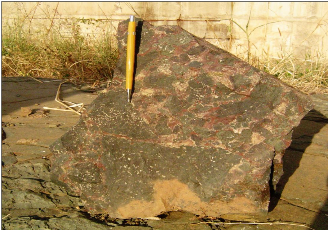
Figura 7.3 - Brecha magmática constituída por fragmentos de arenito e basalto na base do derrame da foto anterior. Localizado na eclusa 01 da UHT (Ponto 2006/TU-02).
