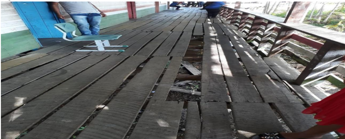
Figura 6 – Pátio de Acesso as Salas de Aula
