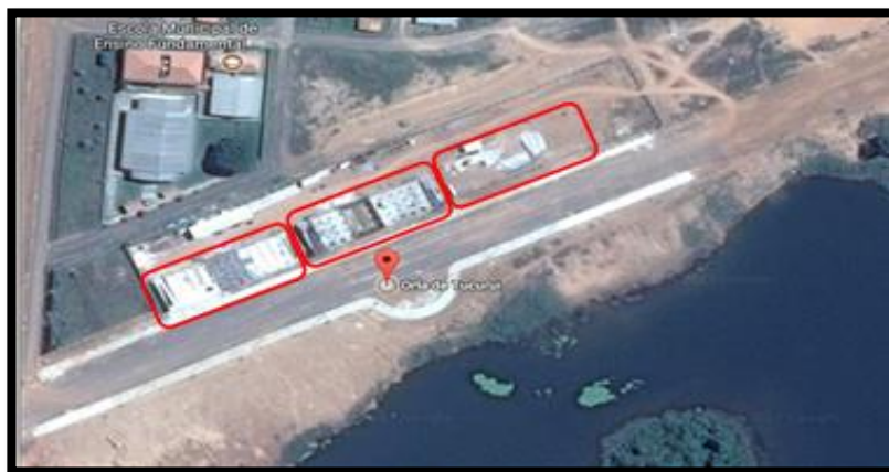
Figura 5 – Vista aérea do canteiro de obra do Complexo Cultural e Orla
