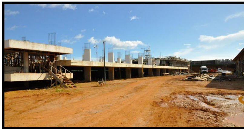
Figura 7 – Frente da obra - 2017
