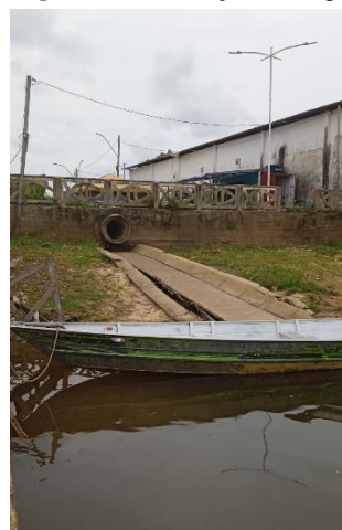
Figura 6: Tubulação de esgoto
