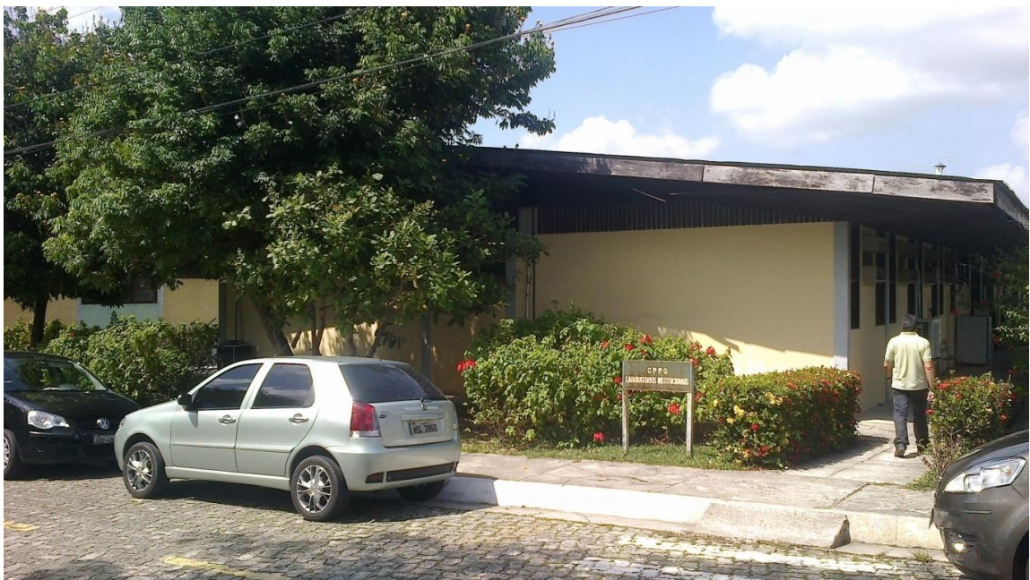
Figura 14: Prédio do acervo de paleontologia. Nota-se a proximidade com a circulação de carros dentro do campus do MPEG. Fonte: Doriene Monteiro.
