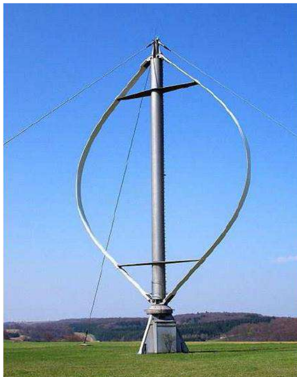
Figura 2: Aerogerador de eixo vertical
