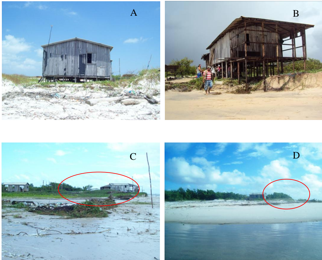
Figura 21 - Erosão evidenciada pela destruição de casas acima da LMA próximo ao perfil t4. A) Setembro/2009 B) Janeiro/2010 C) Janeiro/2010 D) Maio/2010.
