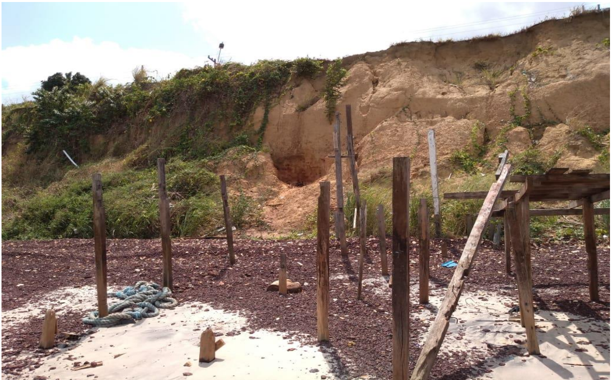
Ilustração 7- Continuação da identificação das falésias existentes na Praia da Vila do Conde.
