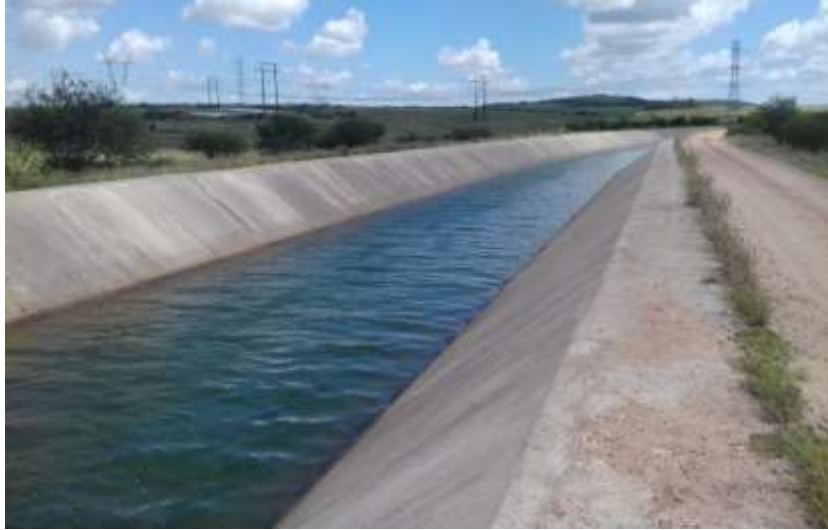
Figura 18 – Canal do tipo convencional de seção trapezoidal
