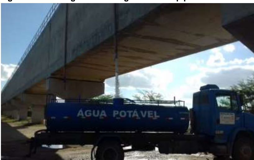
Figura 119 - Carregamento de água no carro pipa no Povoado Luciano
