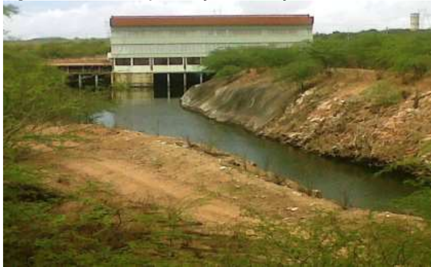
Figura 13 – Canal de aproximação até Estação elevatória
