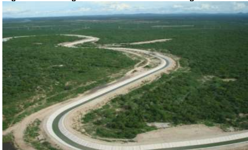
Figura 14 - Visão geral do Canal do Sertão de Alagoa
