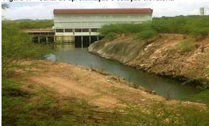
Figura 17 - Canal de aproximação e estação elevatória
