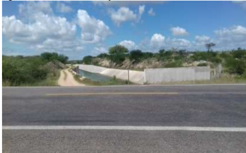
Figura 20 - Galeria de interseção entre o canal e a Rodovia BR 423
