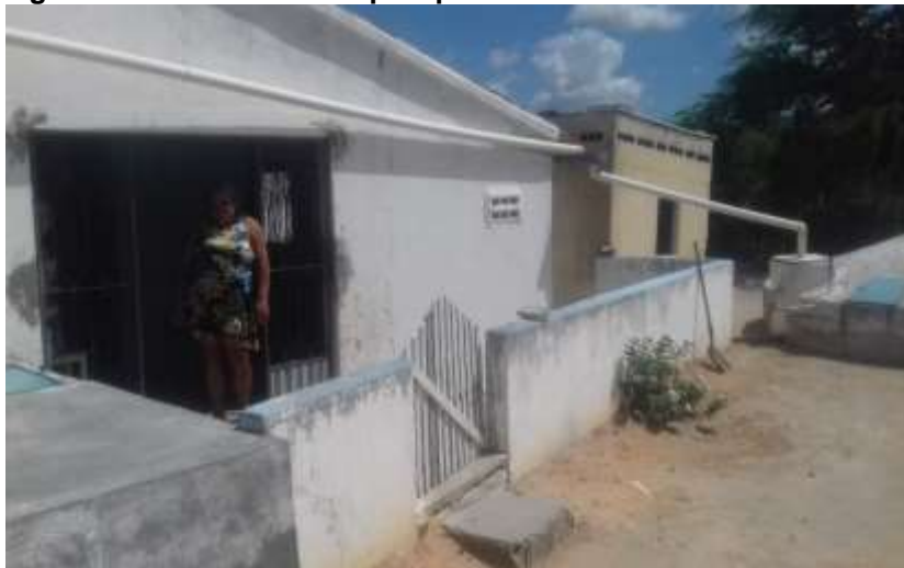
Figura 113 - Povoado Tanque após entrevista com moradora
