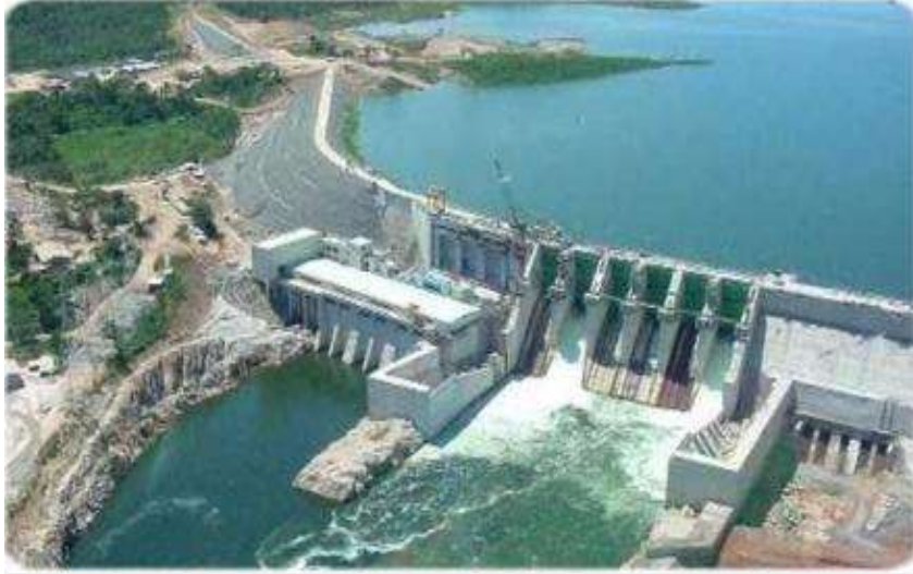
Figura 12 - Usina Hidrelétrica Apolônio Sales no reservatório do Moxotó
