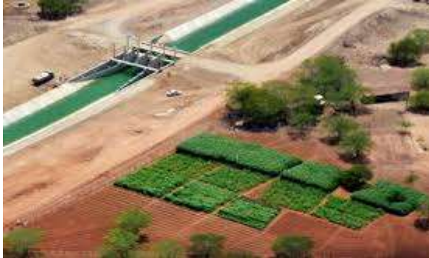
Figura 22 - Ponte para travessias de pedestres e animais
