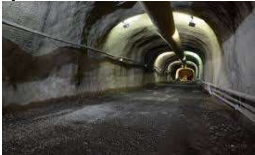
Figura 23 – Túnel sobre o canal
