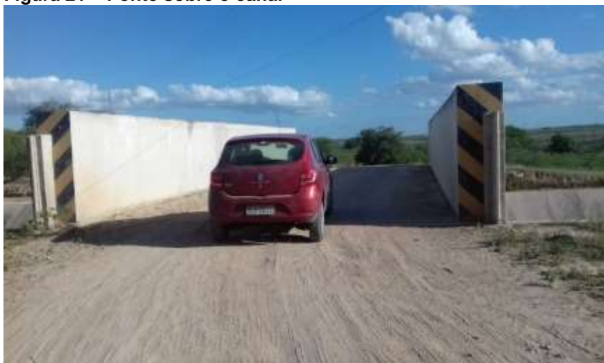
Figura 21 – Ponte sobre o canal
