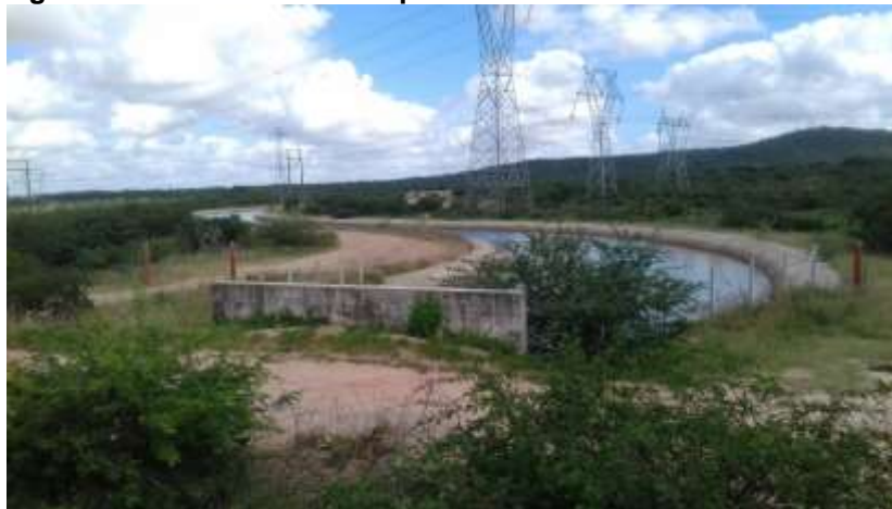
Figura 121 - Canal do sertão próximo ao acesso Distrito Alto dos Coelhos
