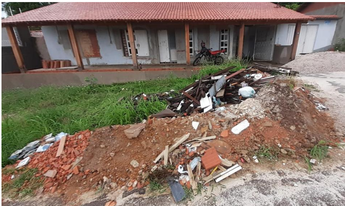
Figura 14 – Materiais dispostos sem segregação adequada em obras residenciais
