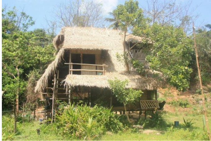
Figura 19 – Arquitetura nativa. Construtor: Genelson Pinto Fonte: Flávia Souza/2015
