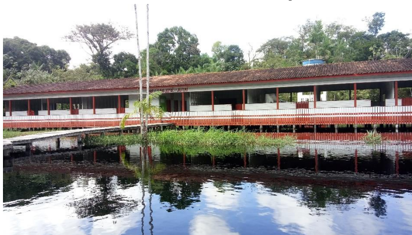
FIGURA 4: Foto da escola São José do Jutai, de Gurupá, no Pará, 2017.
