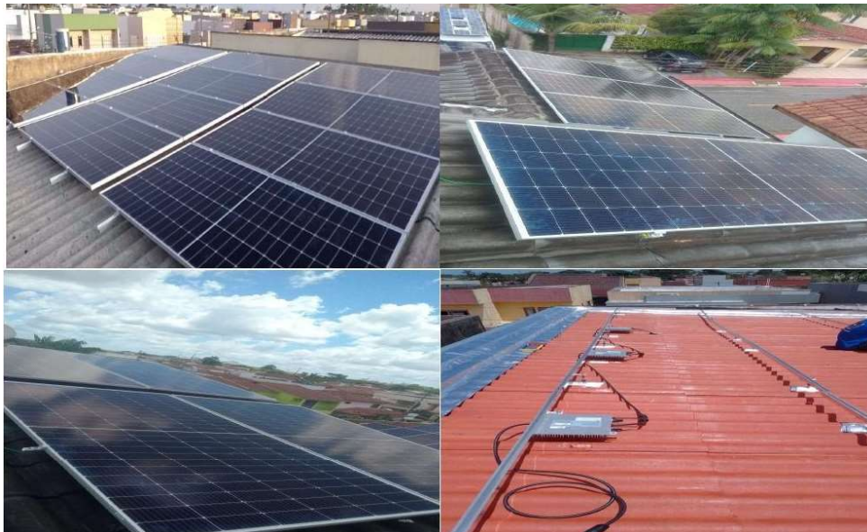
Figura 2: Instalação dos módulos solares fotovoltaicos e micro inversores.
