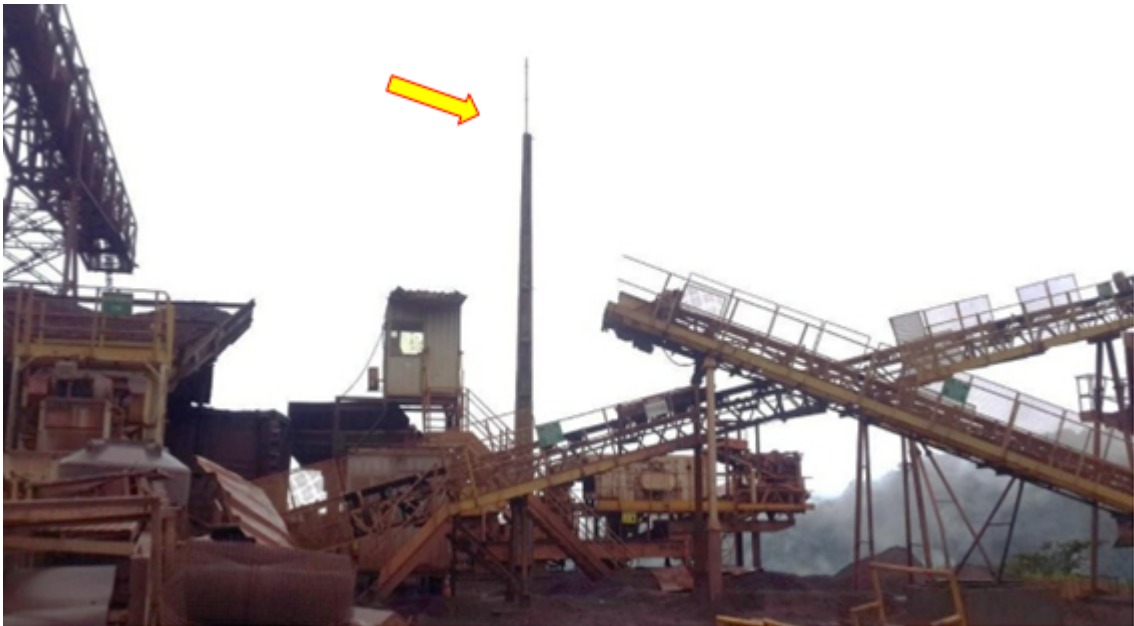
Figura 19 – Captores implantados SPDA área operacional
