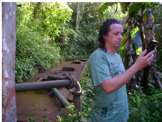
Figura 23 – Mina Pacal – Local de Captação de Água
