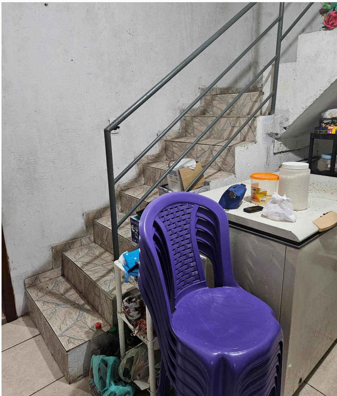
Figura 21 – Escada de acesso ao nível superior, 2025.
