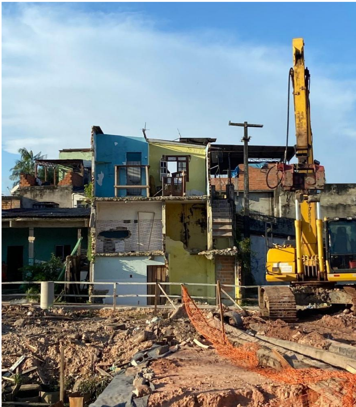
Figura 13 – Imóvel em processo de demolição devido a ação de desapropriação para duplicação da Av. Bernardo Sayão, 2024.
