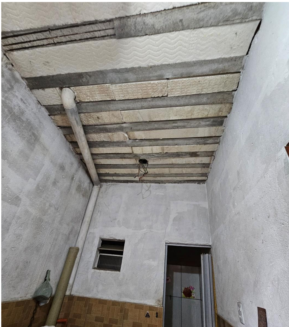
Figura 15 – Laje do pavimento térreo, 2025.
