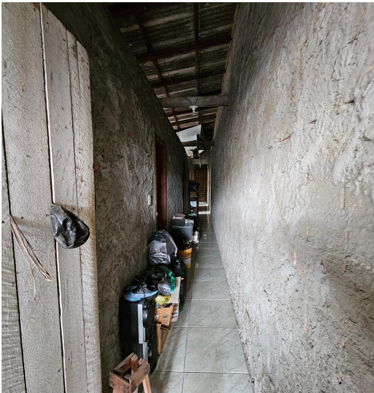
Figura 19 – Corredor do pavimento superior, 2025.
