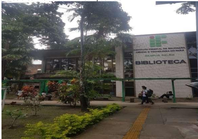
Figura 2 – Fotografia de área interna do IFPA Campus Belém.
