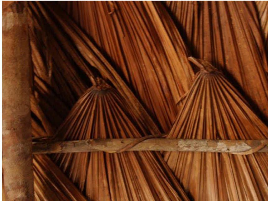
Figura 7 – Teto de palha de caranã
