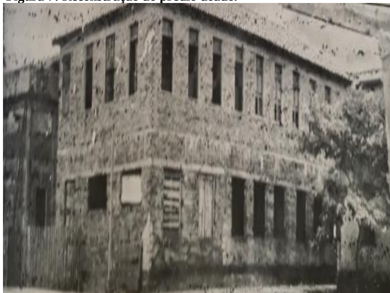
Figura 7: Reconstrução do prédio doado.
