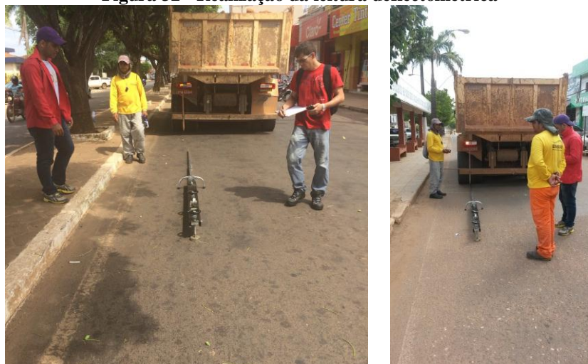
Figura 32 - Realização da leitura deflectométrica
