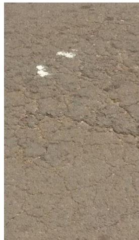
e) Trincas interligadas/Tipo couro de jacaré, 6m x 3,5m (Rua Lauro Sodré)
