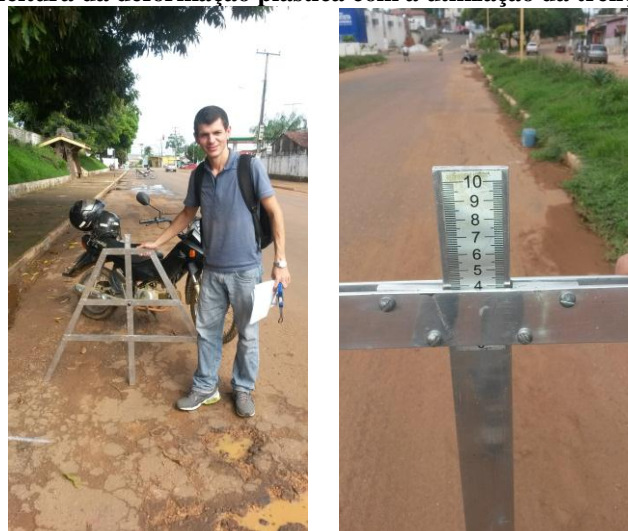
Figura 29 - Leitura da deformação plástica com a utilização da treliça de alumínio
