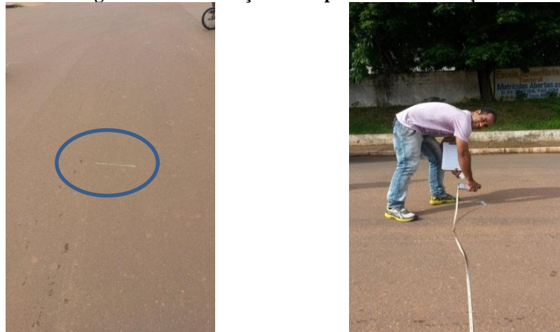
a) Demarcação do estaqueamento
