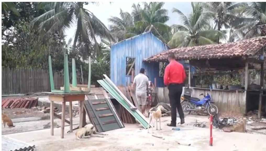
Figura 5 – Demolição de casa de colono na Vila Pepino (Fonte: TV. Piriá - https://www.facebook.com/share/1E2iTdU8D9/ )
