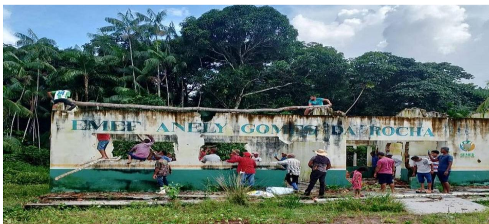
Figura 4 – Demolição da Escola da extinta Vila do Pepino (Fonte: TV. Piriá - https://www.facebook.com/share/1E2iTdU8D9/ )
