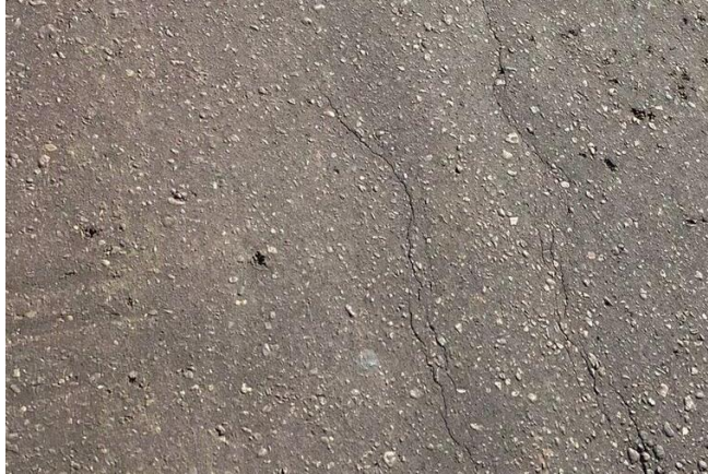
Figura 31 - Trincas isoladas
