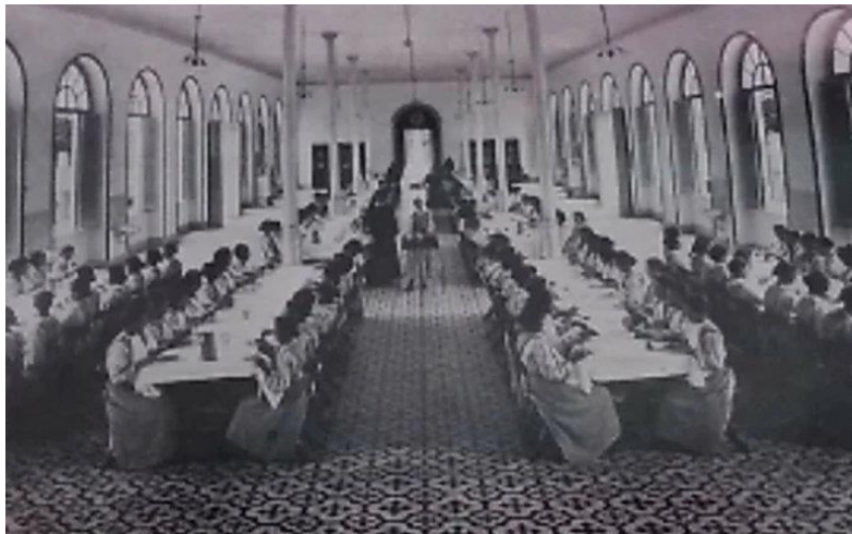
Figura 2. Antigo Refeitório do Colégio Gentil
