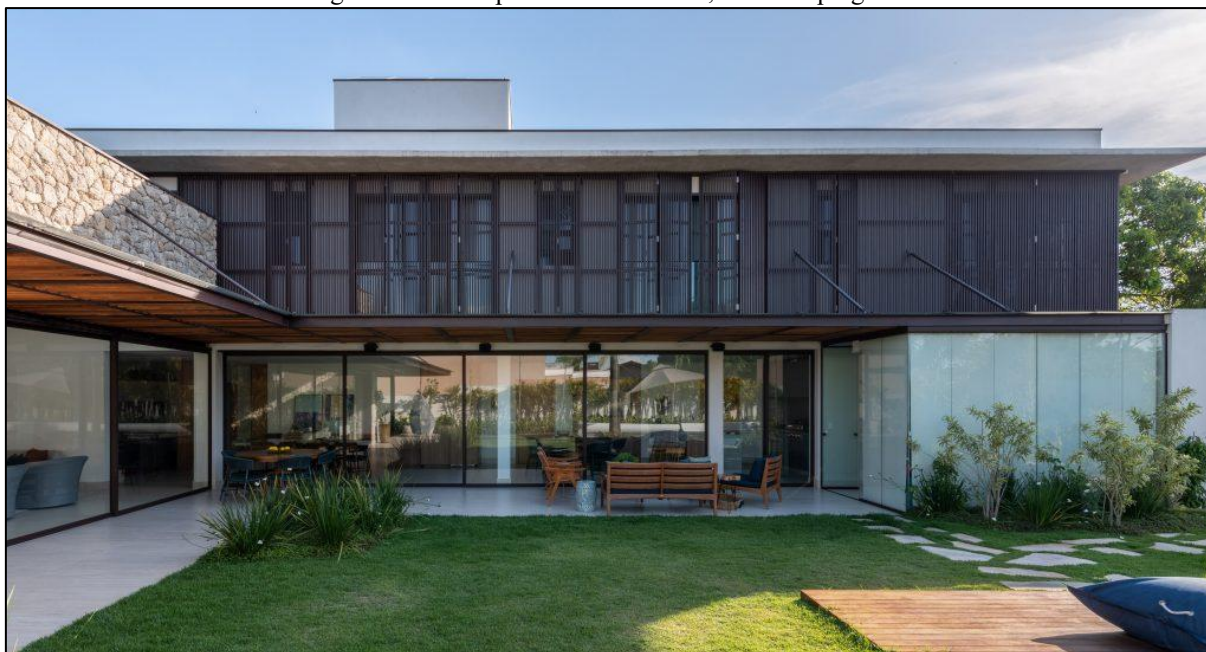
Figura 25 - Exemplo do uso de brises, beirais e pérgolas
