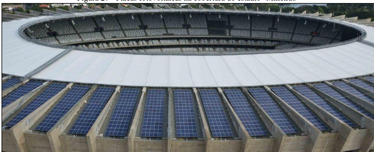
Figura 27 - Placas fotovoltaicas na cobertura do estádio "Mineirão"
