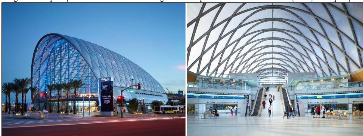
Figura 59 - Aplicação do ETFE no Anaheim Regional Transportation Intermodal Center (EUA) - composição
