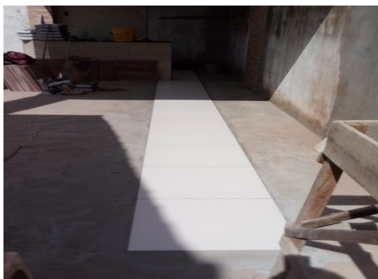
Fig 11: Aplicação de porcelanato (lajota)
