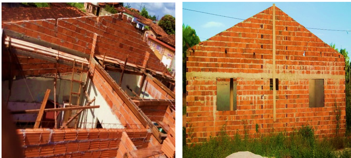
Fig. 13 e 14: Inclinação do telhado
