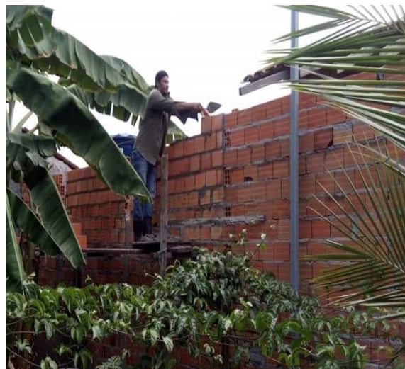
Fig.7: Assentamento de tijolos
