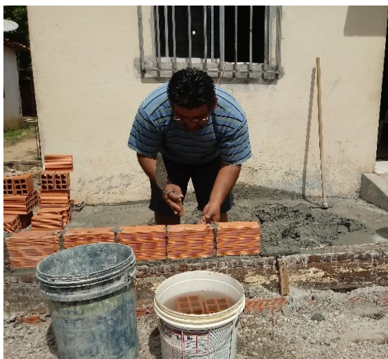
Fig.6: Assentamento de tijolos
