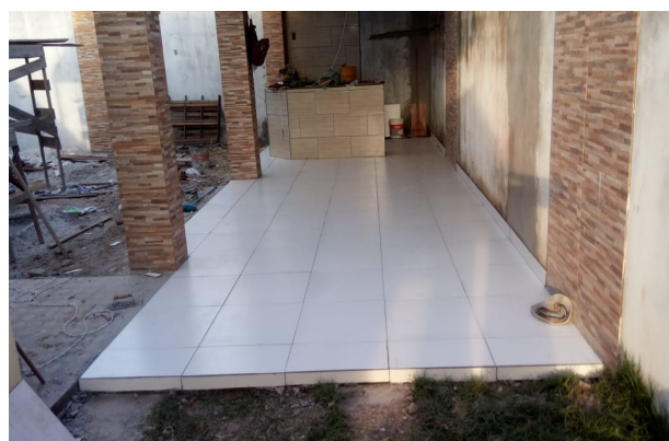
Fig.12: Piso com acabamento
