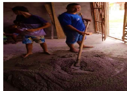
Fig. 16: Preparo de um traço de massa
