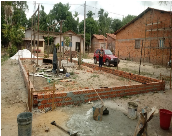
Figura. 1: Base de uma construção já nivelada
