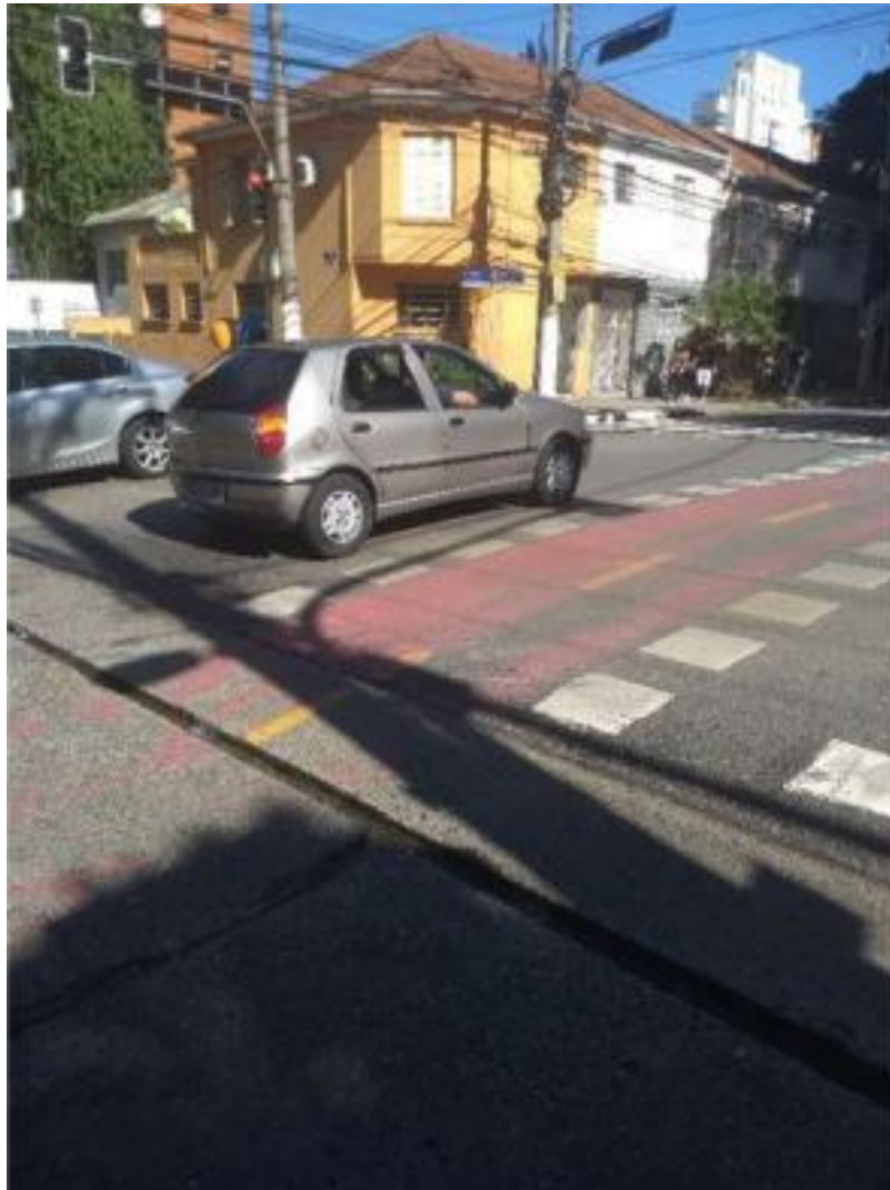
Figura 27 – Exemplo de valetas em intercessões
