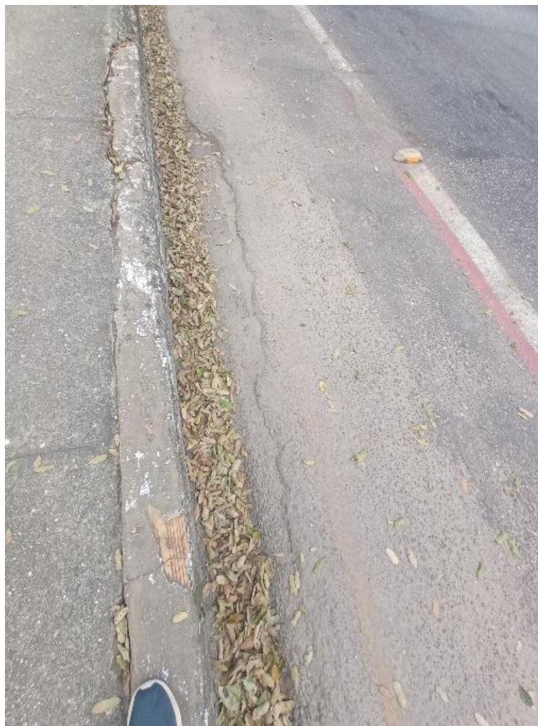
Figura 23 – Exemplo de escorregamento
