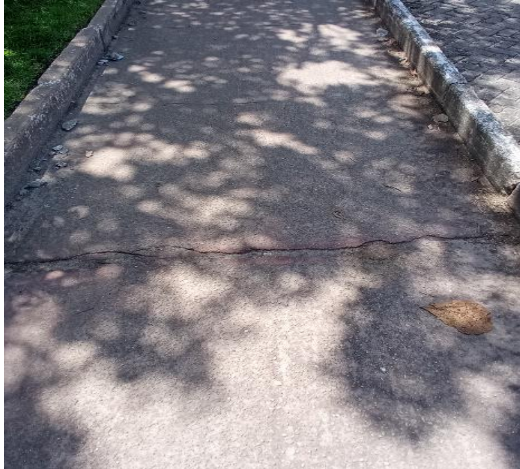
Figura 32 – Exemplo de esborcinamento
