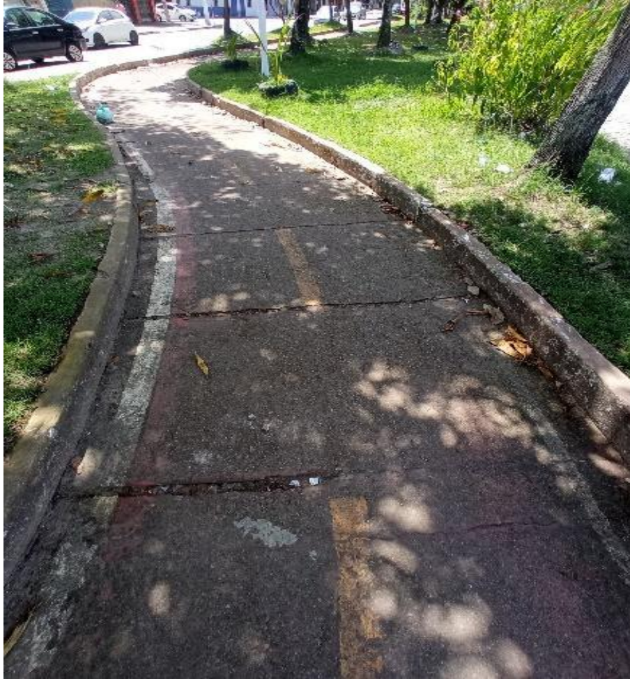
Figura 35 – Exemplo de separação de juntas
