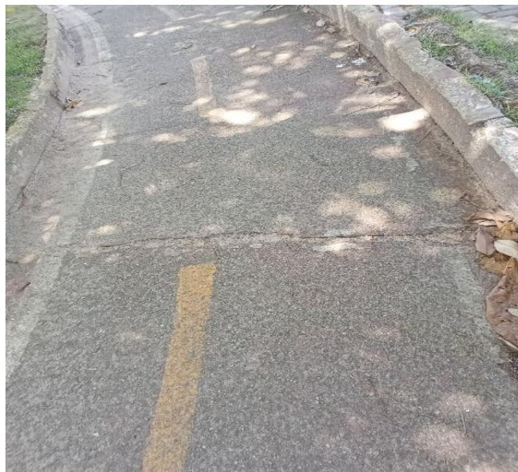
Figura 33 – Exemplo de esborcinamento
