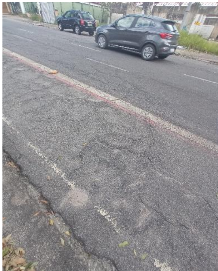
Figura 21 – Exemplo de fissuras, trincas e rachaduras em blocos
