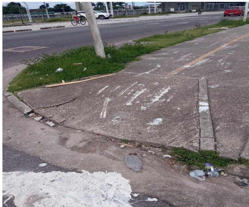
Figura 38 – Exemplo de juntas de transição
