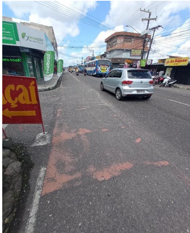
Figura 17 – Exemplo de desgaste da pintura superficial
