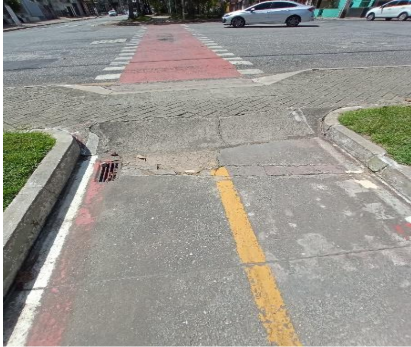
Figura 37 – Exemplo de juntas de transição
