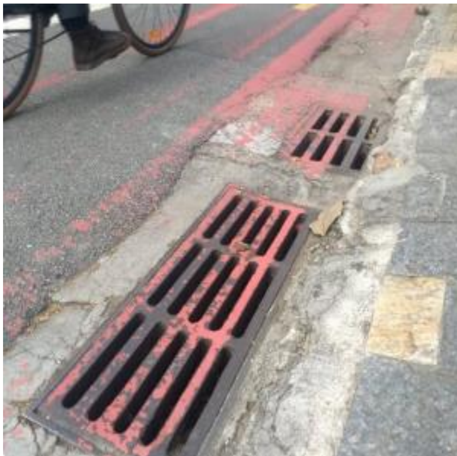
Figura 26 – Exemplo de grelhas de sarjeta com espaçamento longitudinal acentuado
