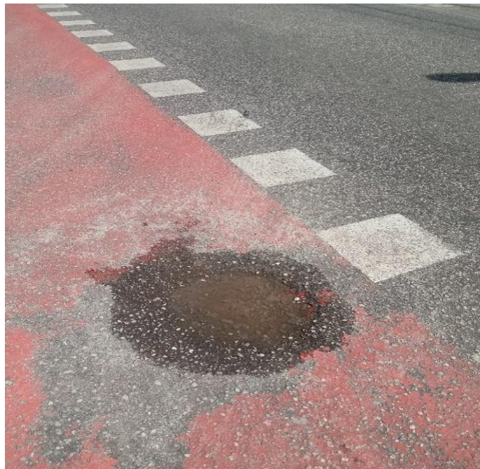
Figura 16 – Exemplo de buraco em pavimento flexível
