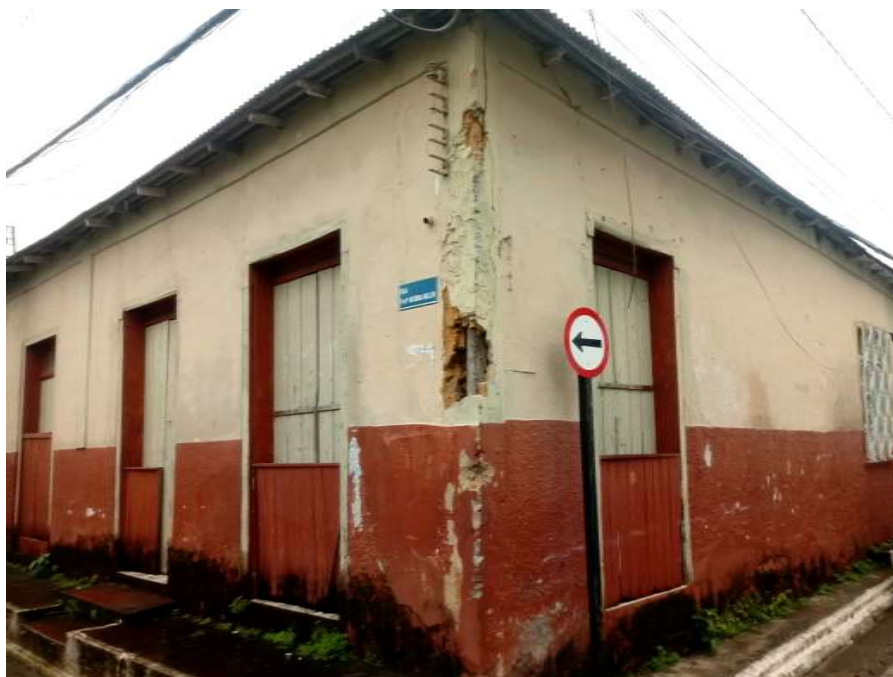
Fotografia 12 – Imóvel histórico com alvenaria exposta de taipa e tronco.
