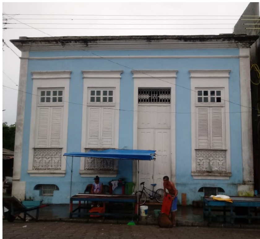
Fotografia 15 – Fachada da antiga sede da Rádio Moreno. Fonte: Camila Trindade, 2019.
