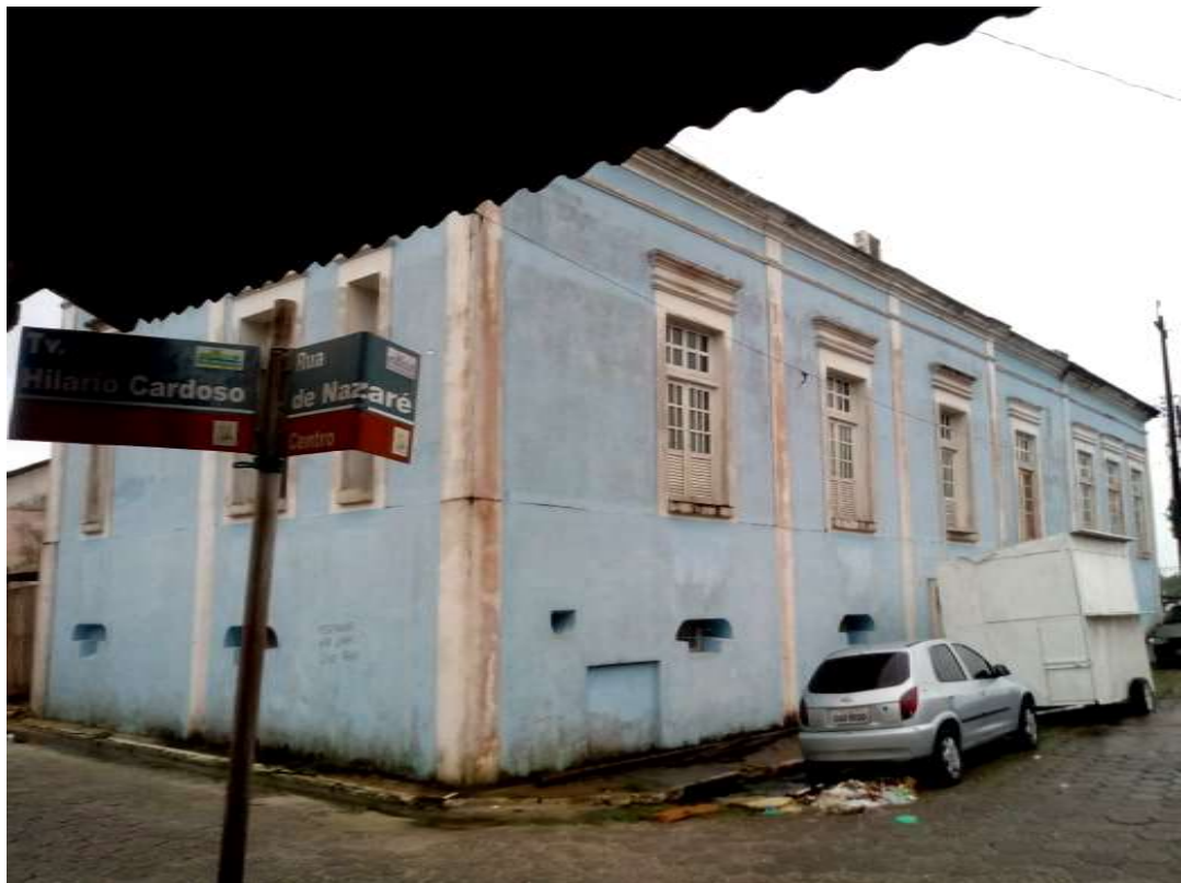
Fotografia 17 – Vista de trás do imóvel. Em destaque, o abandono das fachadas e a dimensão do imóvel.
