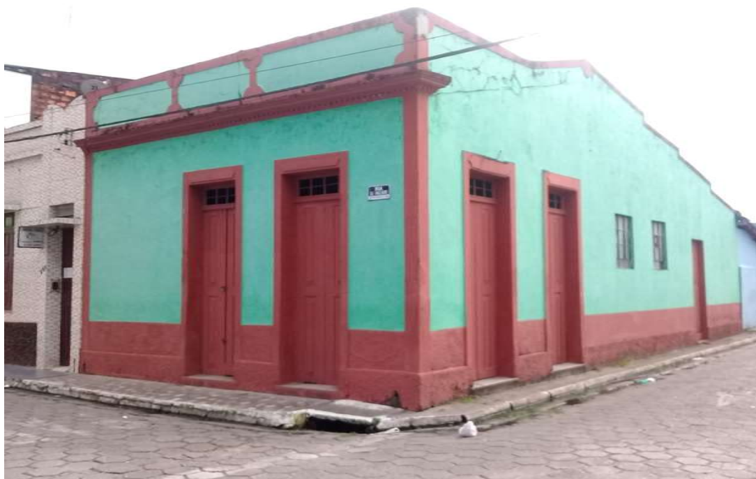
Fotografia 22 – Antiga Padaria Modelo, atualmente usada como depósito privado. Fonte: Camila Trindade, 2019.
