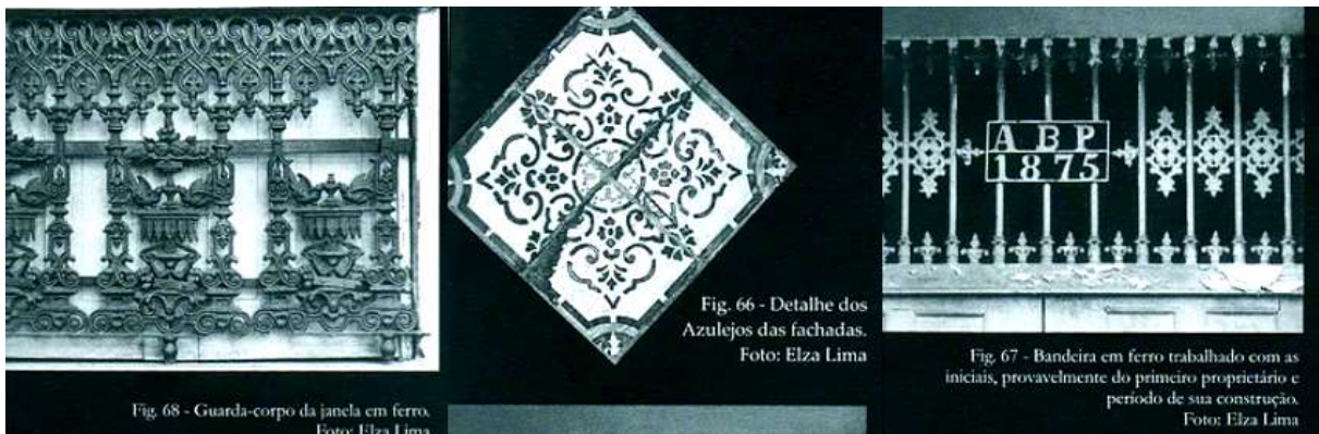
Fotografia 16 – Elementos originais em destaque do casarão. Os azulejos não existem mais.
