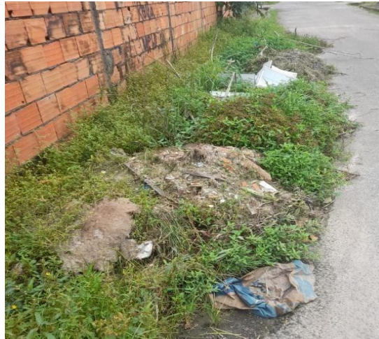
Figura 4 - Calçada com descarte irregular de lixo do Conjunto habitacional Japiim
