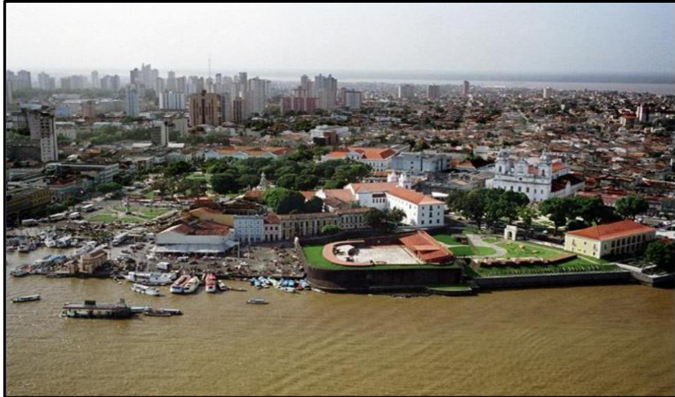
Figura 1 – Vista aérea do Forte do Presépio, Belém, Pará.
