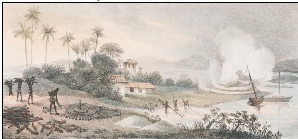
Figura 3 – Fornos de cal (Four à chaux).
