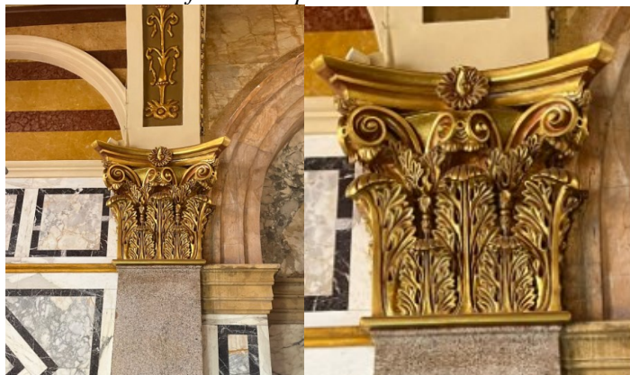
Figura 18: Capitel: após última camada de goma laca, finalizado com acabamento em brilho meio fosco e impermeabilizado
