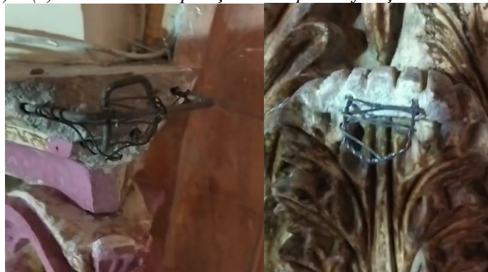
Figura 14: (a) e (b) área de recomposição do capitel e fixação de estrutura metálica.
