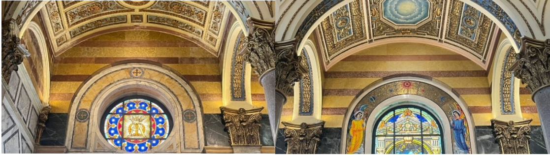
Figura 9: escaiola (a) Danificada, sem intervenções. (b) Corrigida, finalizada.
