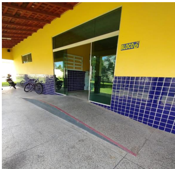
Figura 03- Rampa de acesso à sala do AEE
