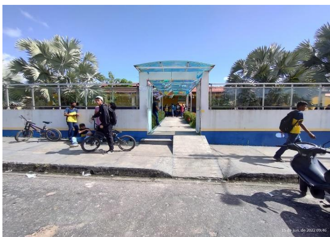
Figura 02- Rampa de acesso à entrada da escola
