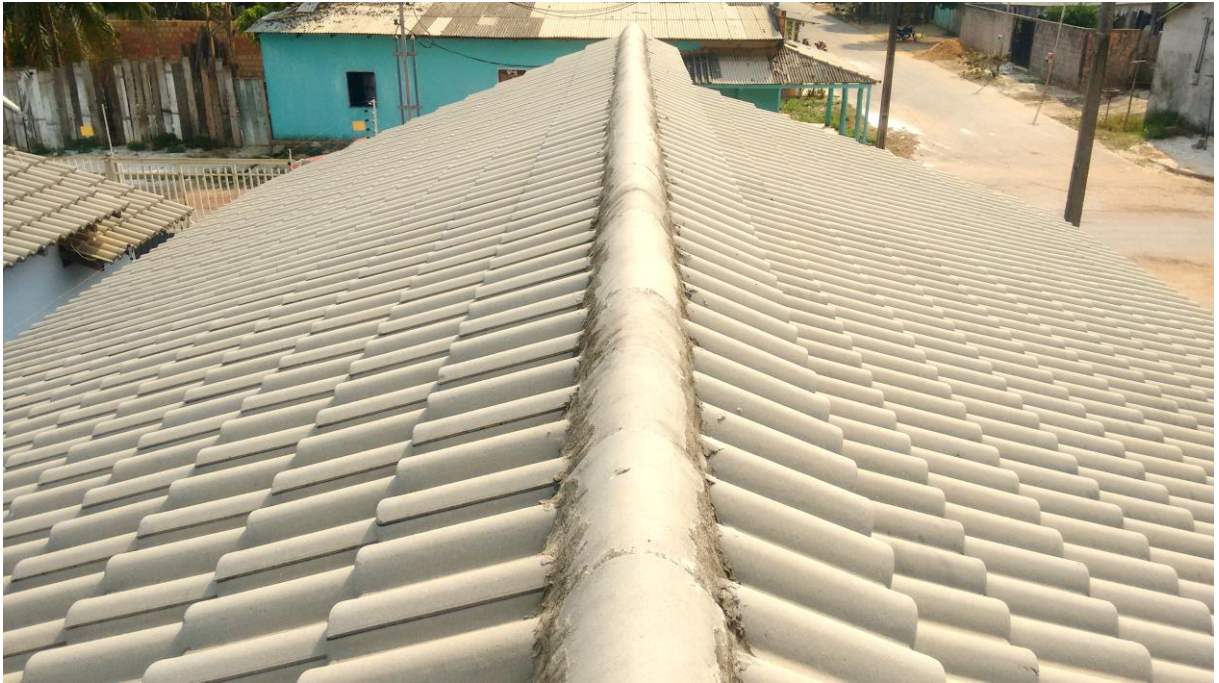
Figura 3.3-4 - Telhado real onde se almeja instalar o sistema projetado.
