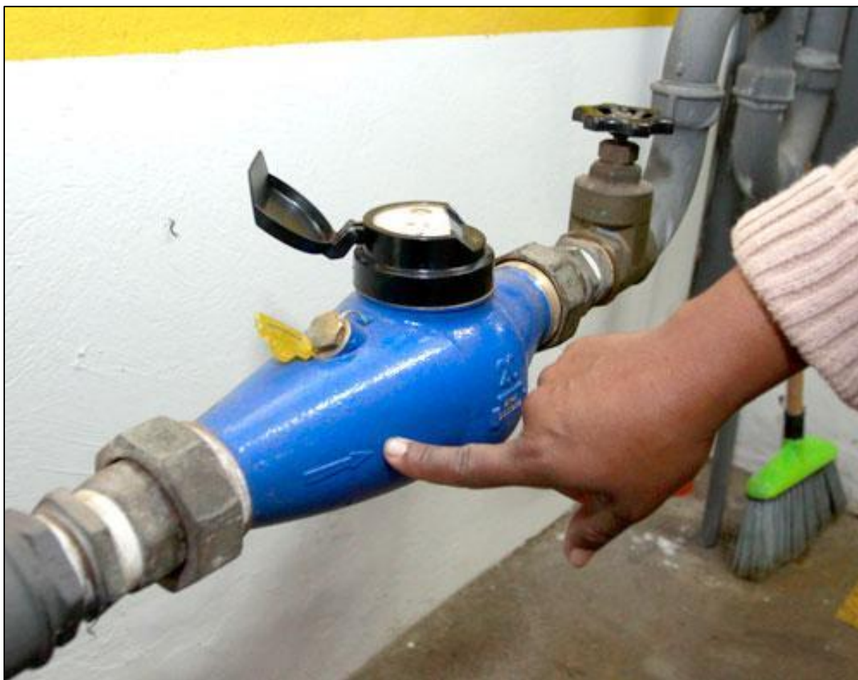
Figura 44 – Ligação com Hidrômetro Invertido Fonte: Autor
