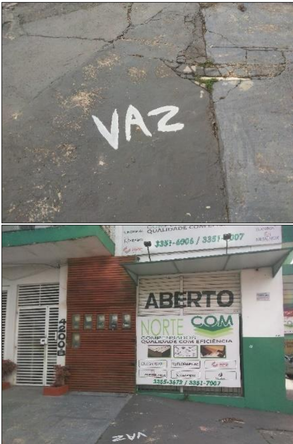
Figura 62 – Marcação de um vazamento não visível em pesquisa diurna Fonte: Autor
