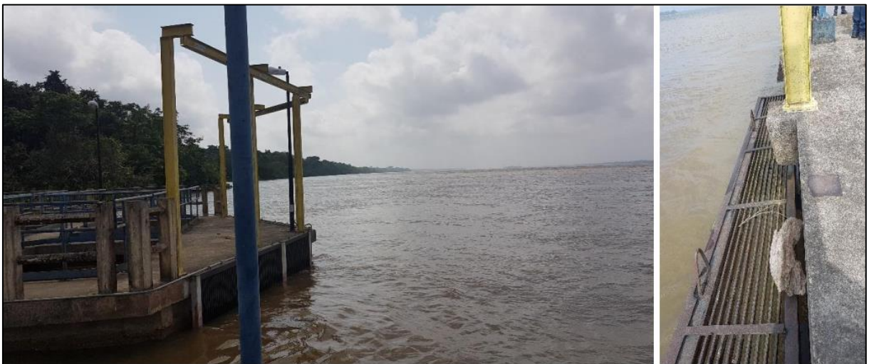
Figura 13 – Gradeamento da Captação de Água Bruta no Rio Guamá Fonte: PMB (2020)
