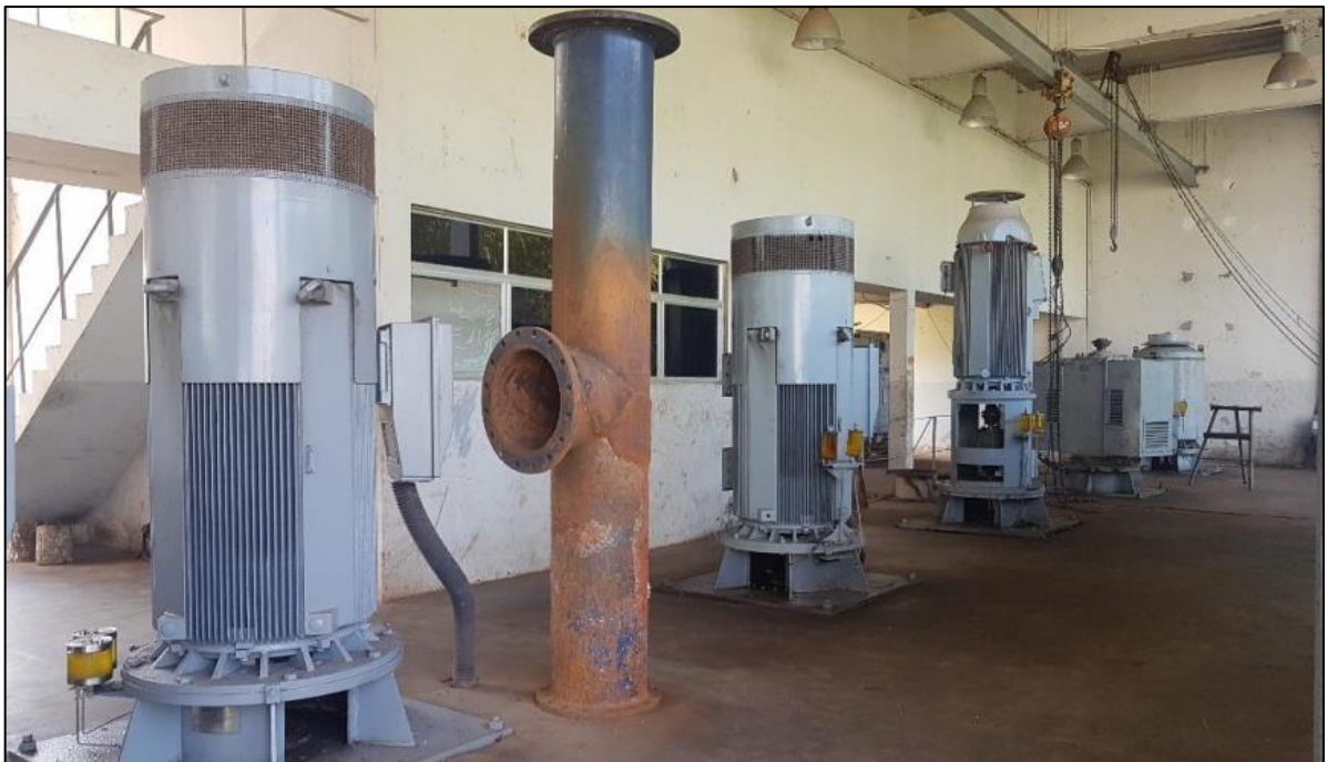
Figura 23 – CMB's do Recalque de Água Bruta do Canal Yuna Fonte: PMB (2020)
