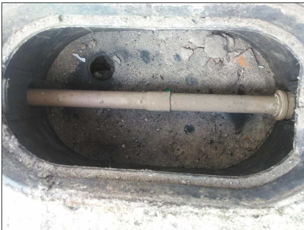
Figura 40 – Ligação à revelia Fonte: Autor
