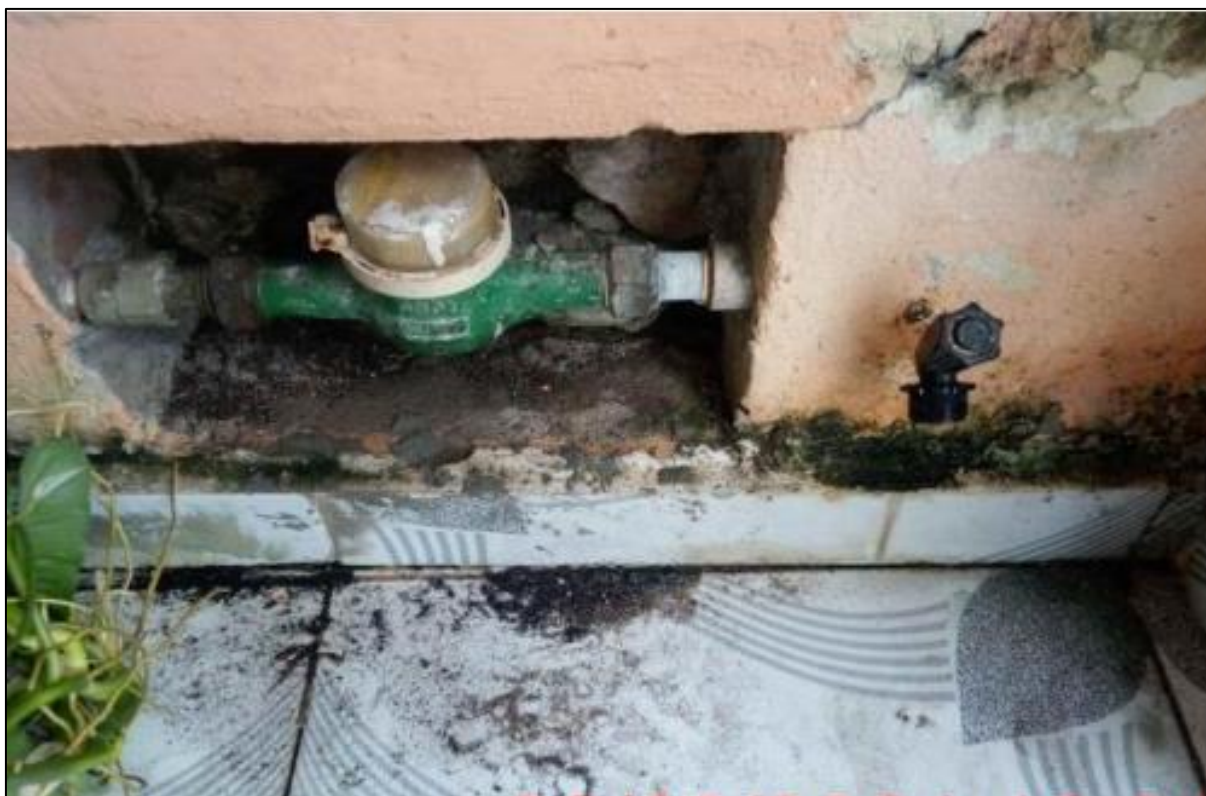
Figura 42 – Torneira antes do hidrômetro, onde o volume de água não é medido, é considerado um by-pass visível
