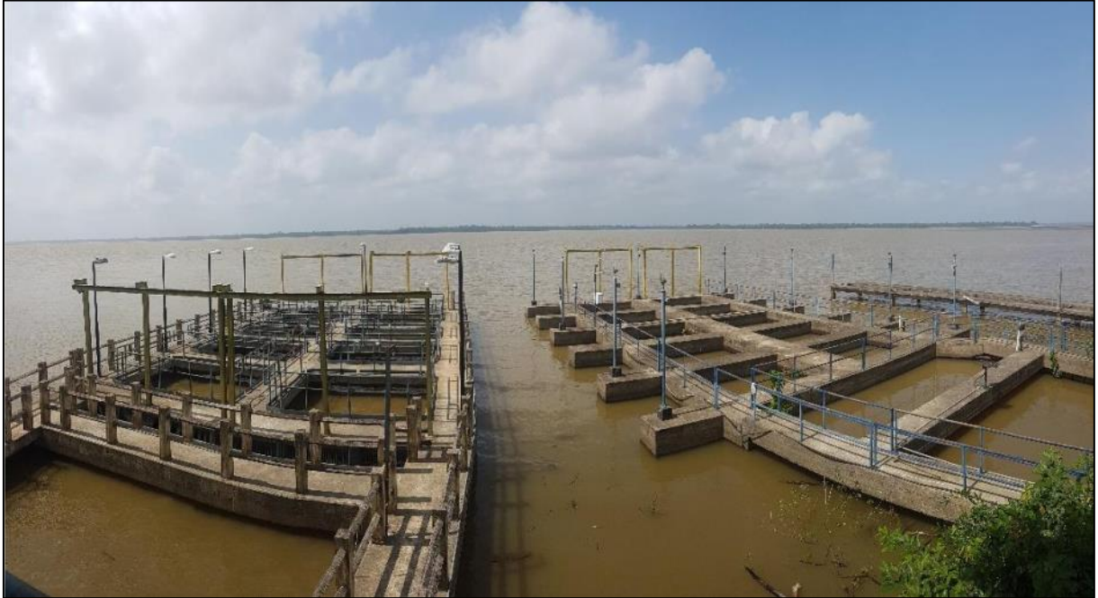
Figura 12 – Captação de Água Bruta no Rio Guamá Fonte: PMB (2020)
