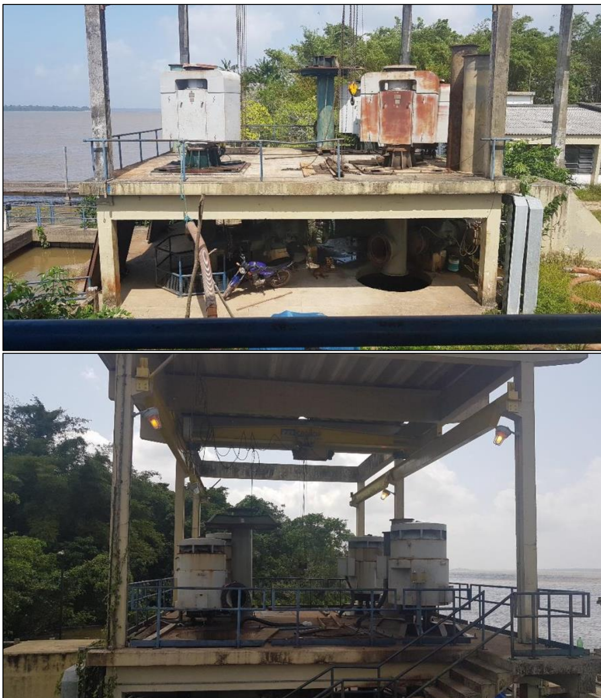
Figura 15 – Estruturas antiga (1975) e estrutura nova (2010) do Recalque de Água Bruta do Rio Guamá, respectivamente Fonte: PMB (2020)
