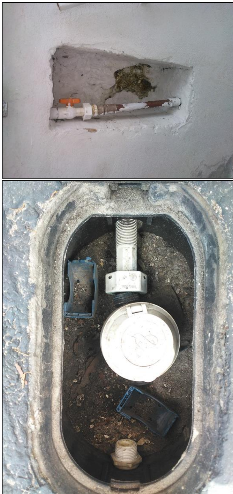
Figura 43 – Ligação sem Hidrômetro Fonte: Autor
