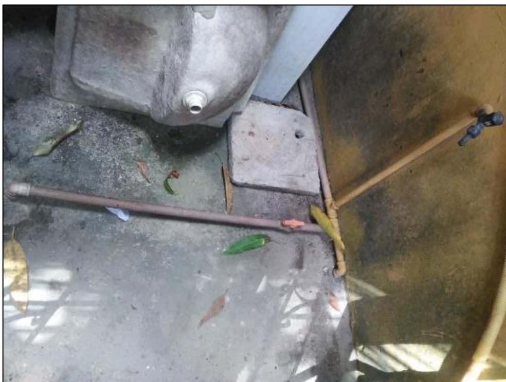
Figura 39 – Fornecimento de água ao vizinho Fonte: Autor
