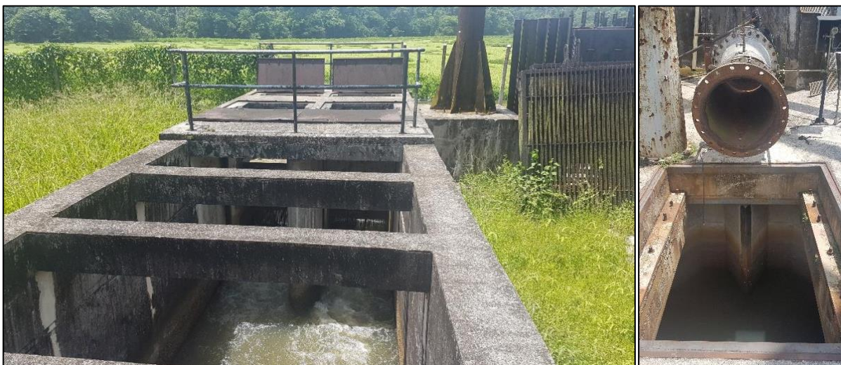
Figura 21 – Captação de Água Bruta no Lago Bolonha e poço de sucção Fonte: PMB (2020)
