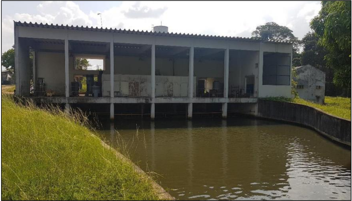
Figura 22 – Captação de Água Bruta do Utinga Fonte: PMB (2020)
