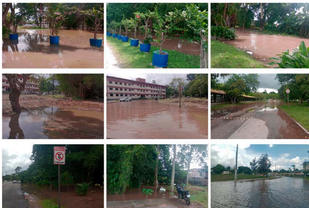
Figura 17 - Pontos de alagamento nos arredores e no interior do Sapucajuba.
