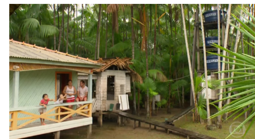
Imagem 95: Estrutura para a filtração de água do rio, aplicada na Ilha das Cinzas (PA). Fonte: Globo Rural, 2018.
