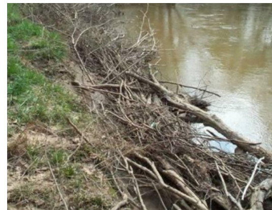
Imagem 114: Exemplo da aplicação de revestimento com árvores na margem do rio. Fonte: Schmeier, 2012.
