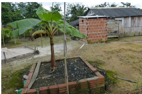
Imagem 104: “Fossa de bananeira” construída em área rural de Parintins (AM). Fonte: Acrítica.com, 2016.
