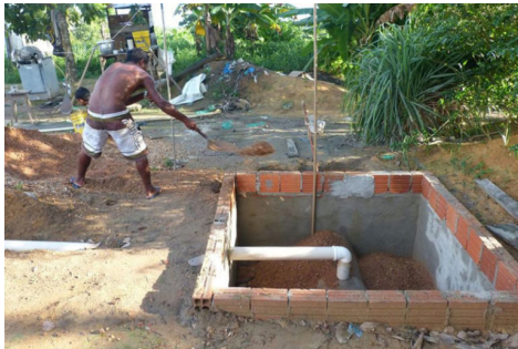
Imagem 103: Construção de uma “fossa de bananeira” em área rural de Parintins (AM). Fonte: Acrítica.com, 2016.
