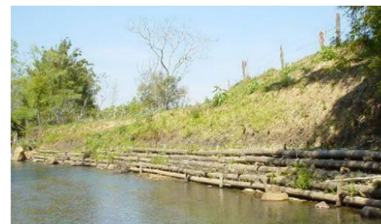
Imagem 115: Exemplo da aplicação da parede Krainer na margem do rio. Fonte: Schmeier, 2012.
