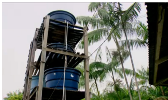
Imagem 94: Estrutura para a filtração de água do rio, aplicada na Ilha das Cinzas (PA). Fonte: Globo Rural, 2018.
