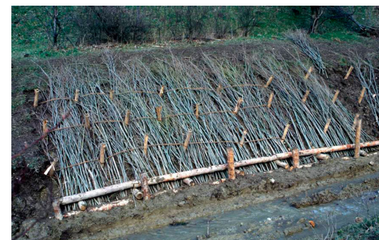
Imagem 116: Exemplo da aplicação da esteira viva na margem do rio. Fonte: Schmeier, 2012.
