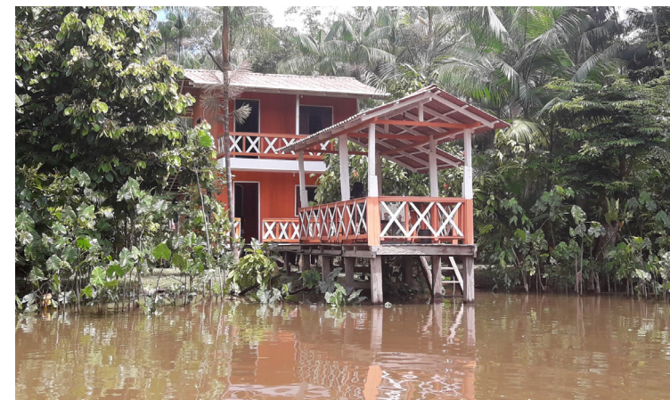
Imagem 26: Casa localizada na Ilha do Combu, em um terreno de marinha. Fonte: autor, 2018.
