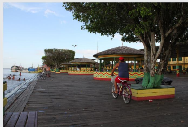
Praça da Quadra em Afuá - Trapiche - Quiosques, quadra poliesportiva, espaço para apresentações - Rampa para banho de rio - Arborização
