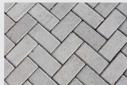
Piso de concreto intertravado Fonte: https://br.pinterest.com/pin/353251164504887109/
