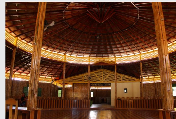
Espaço cultural Lagostão em Afuá - Diálogo com as técnicas construtivas das casas do entorno - Ventilação e iluminação naturais - Espaço multiuso
